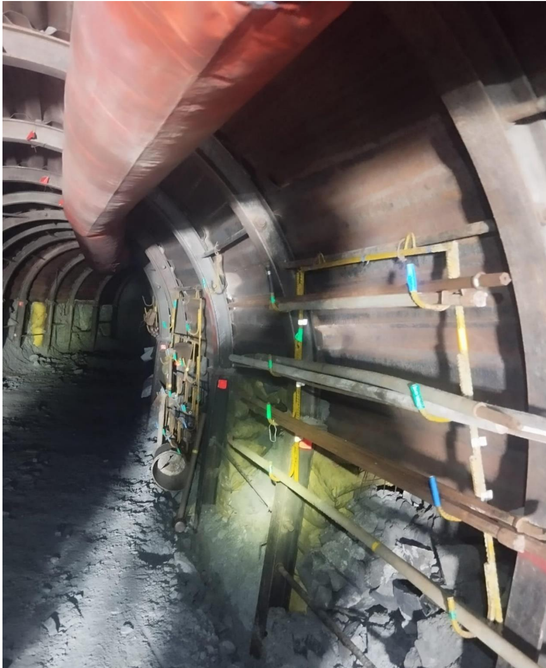
Inspección de barretillas para la labor de avance BP2573
