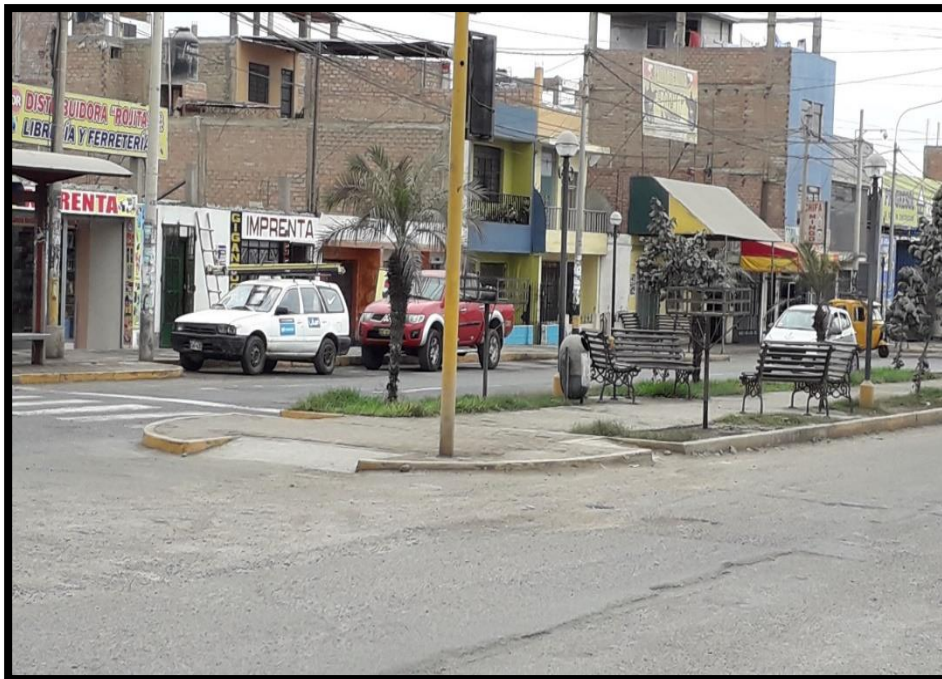
Figura 11. Falla por grietas de fisura en bloque
