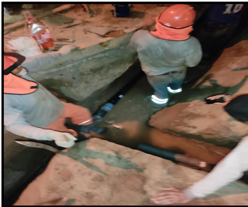
Figura 26. Trabajo de colocación de empalmes e instalación de accesorios.
