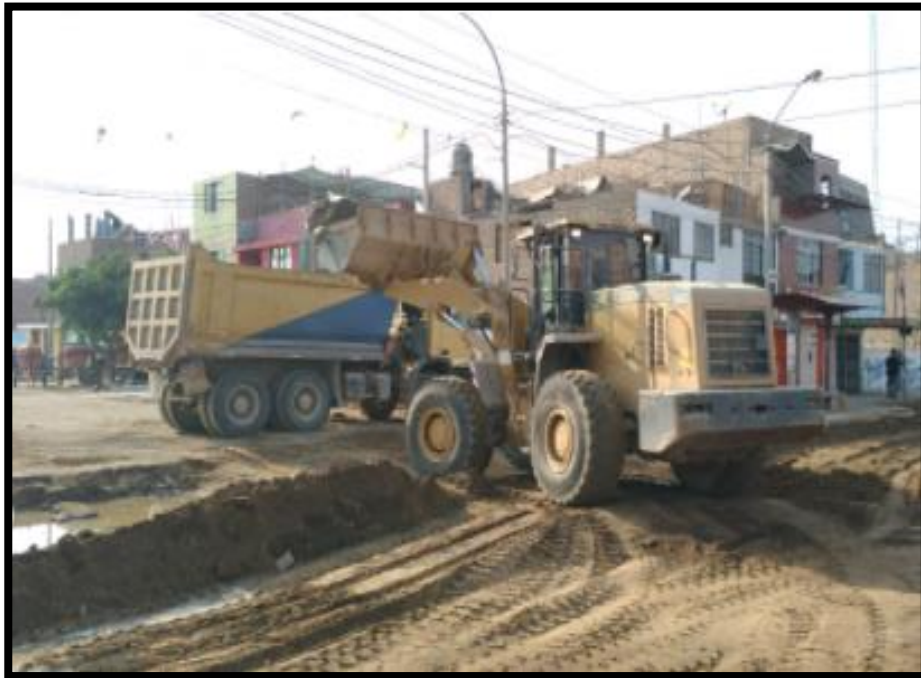
Figura 29. Conformación y Eliminación del material excedente.
