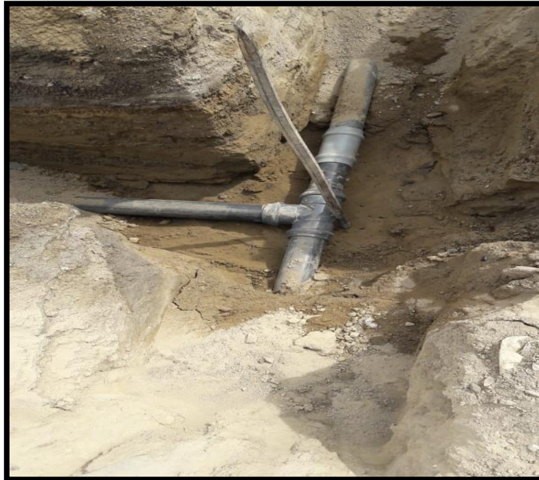
Figura 27. Excavación para cambio de red y sus diferentes estratos.
