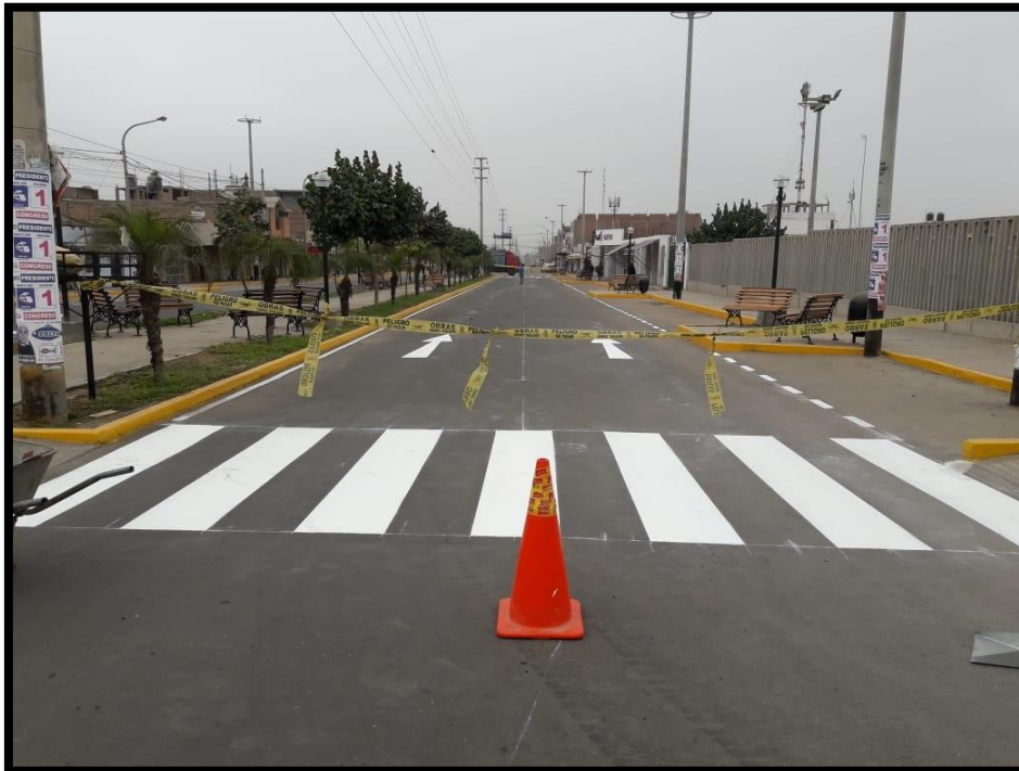
Figura 10. Pavimento Flexible terminado
