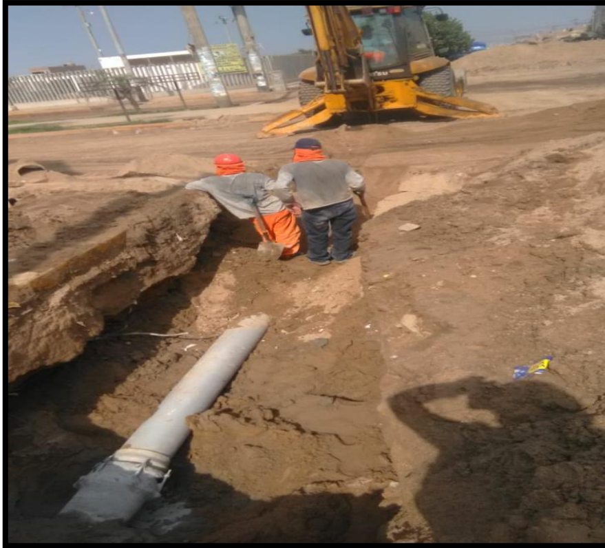
Figura 25. Trabajo de colocación de unión de Tuberías.
