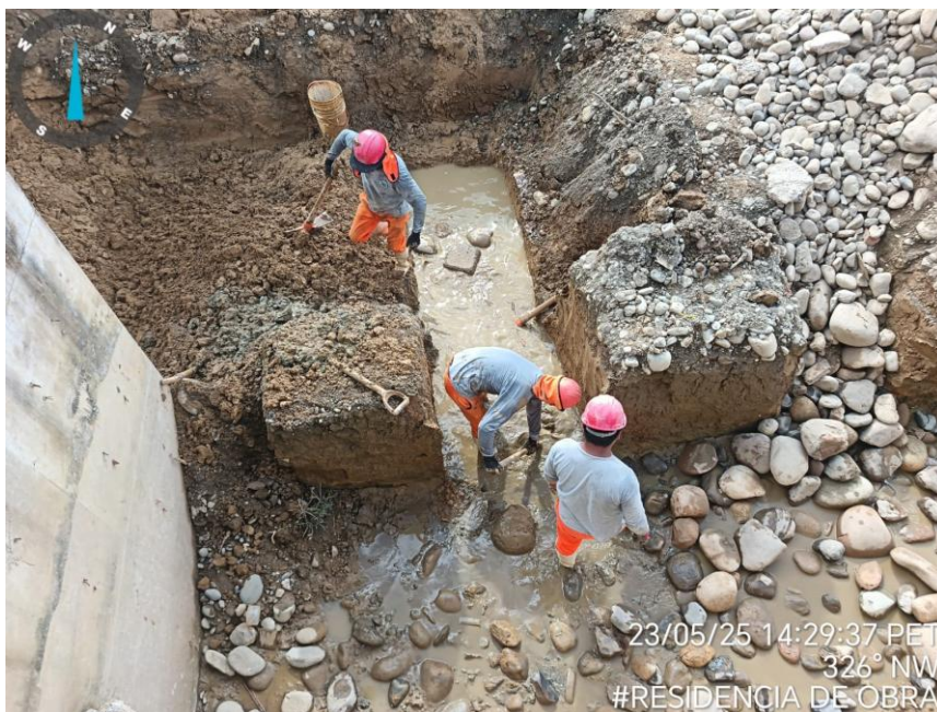
Figura 2 Mejoramiento de suelo en rampa en el bloque OE-06
