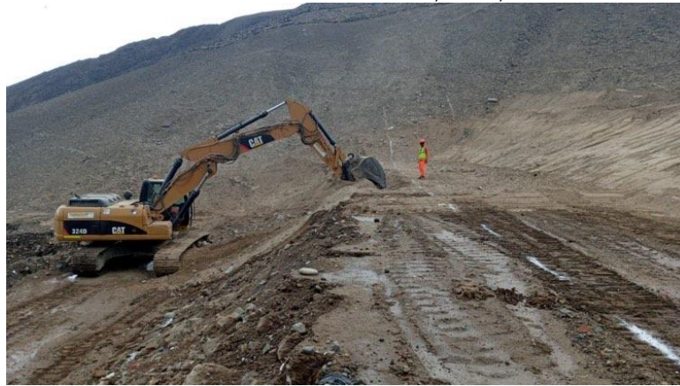
Figura 12. Corte de material con Excavadora sobre orugas.
