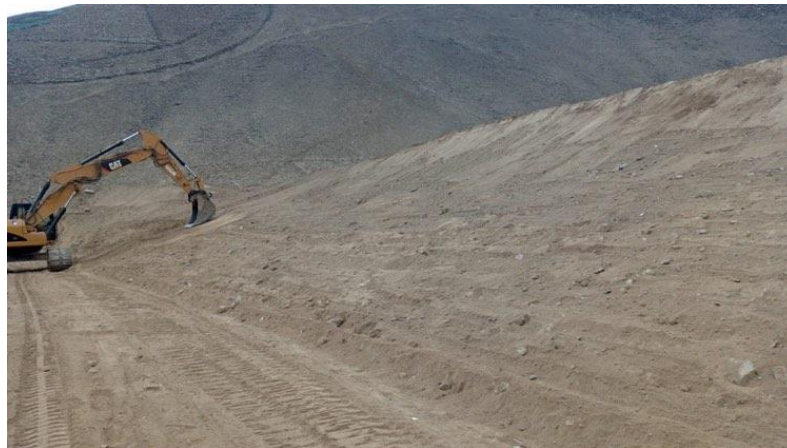
Figura 13. Perfilado de talud con Excavadora sobre orugas. En este proceso se observa que el operador, con ayuda de la máquina, está realizando el perfilado del talud. Este se guía con marcas estratégicamente posicionadas por la cuadrilla de topografía.
