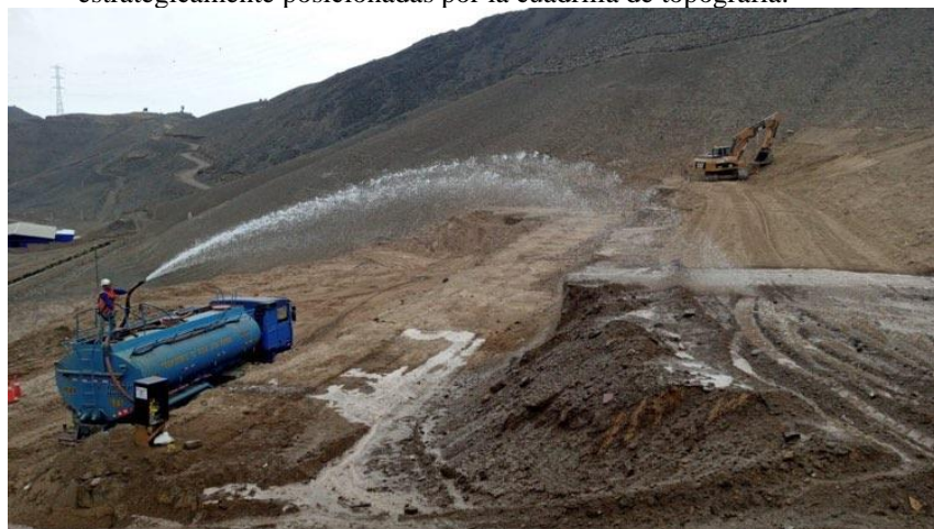
Figura 13. Perfilado de talud con Excavadora sobre orugas. En este proceso se observa que el operador, con ayuda de la máquina, está realizando el perfilado del talud. Este se guía con marcas estratégicamente posicionadas por la cuadrilla de topografía.
