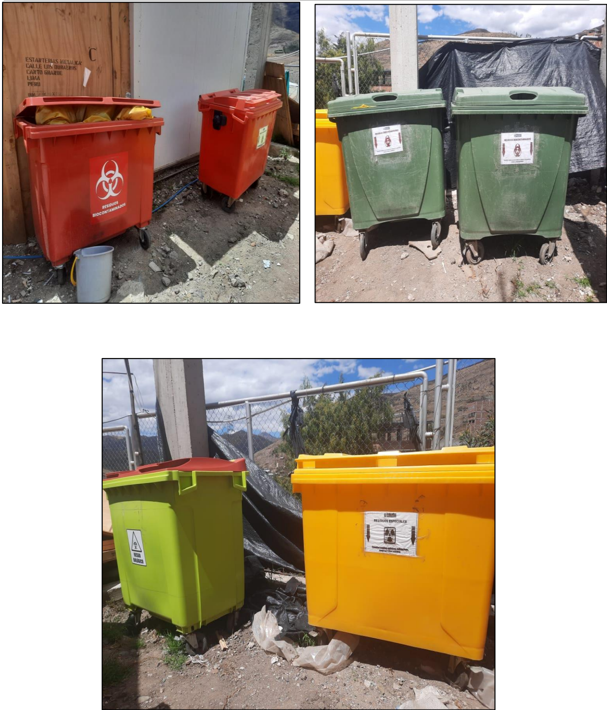
Figura 28. Mala ubicación del área destinada para el almacenamiento de residuos Biocontaminados, Comunes y Especiales.
