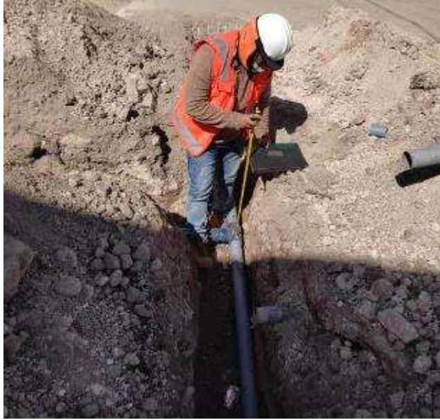
Figura 31 Instalación de tuberías y accesorios de PVC
