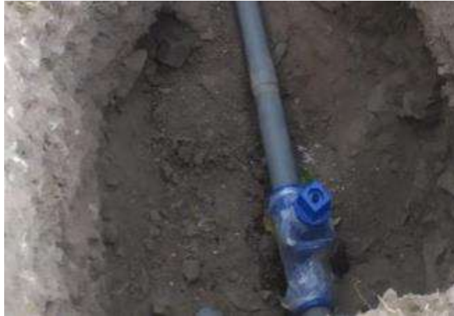
Figura 33 Instalación de válvulas de control
