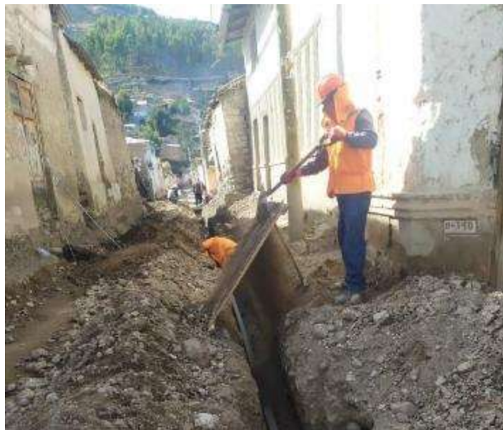
Figura 32 Relleno con material propio
