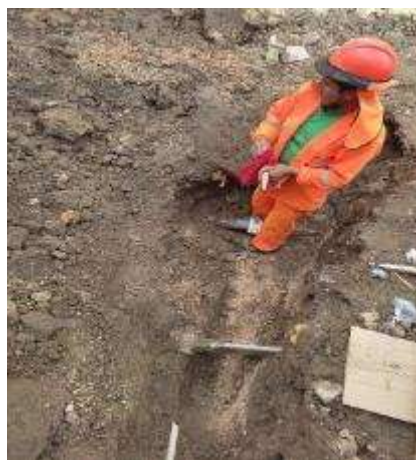
Figura 34 Instalación de conexiones domiciliarias con abrazaderas de PVC
