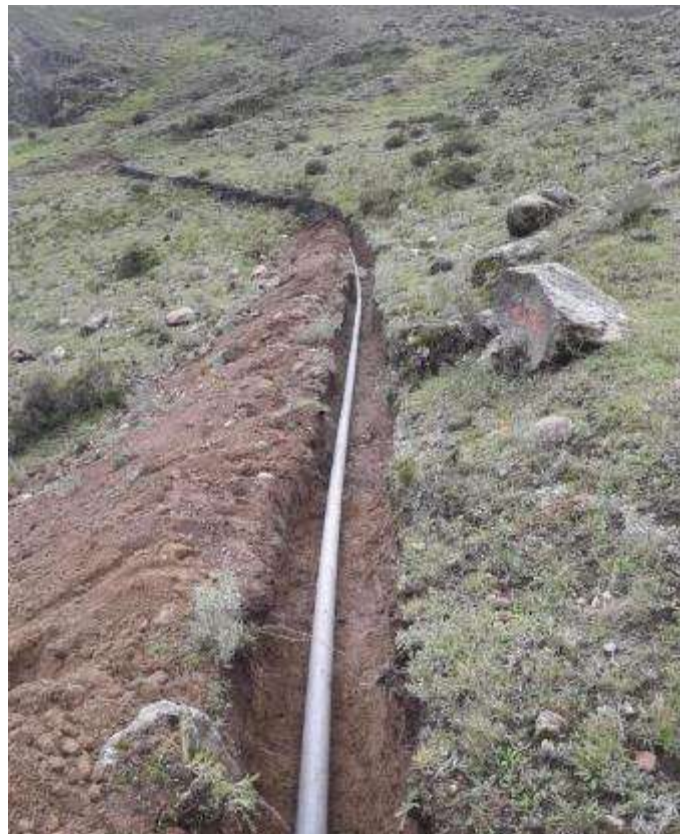
Figura 6 Línea de conducción para dotación de agua potable localidad de Chipao
