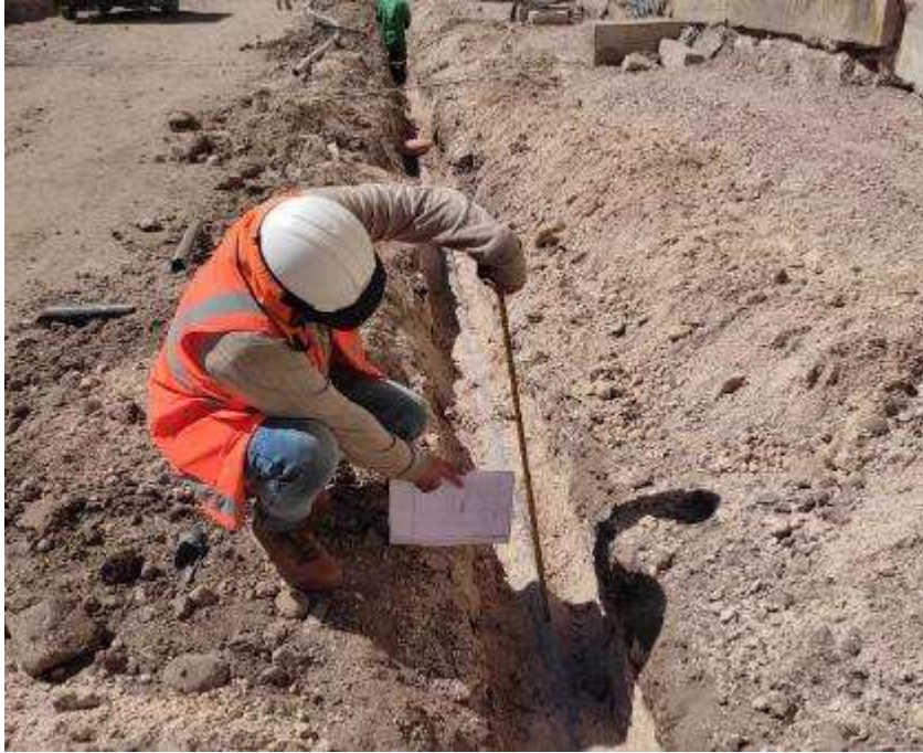
Figura 30 Cama de apoyo con arena cernida en Av. Cuba
