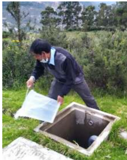
Figura 11 Aforo por el método volumétrico
