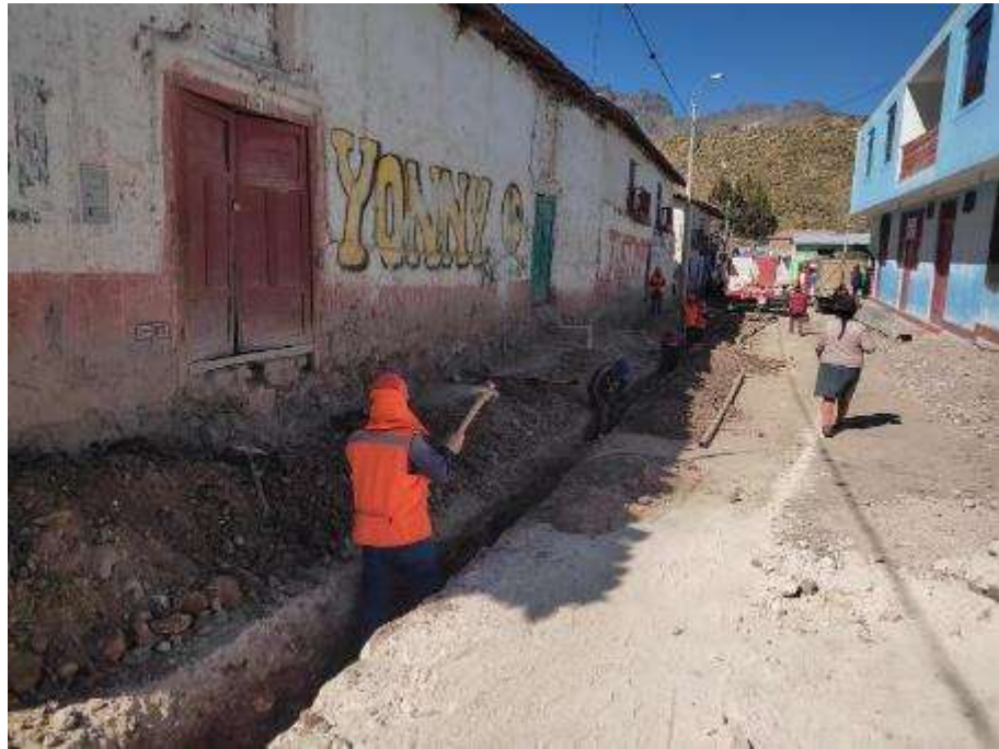
Figura 28 Excavación de zanja manual para instalación de tuberías en la Av. Cuba
