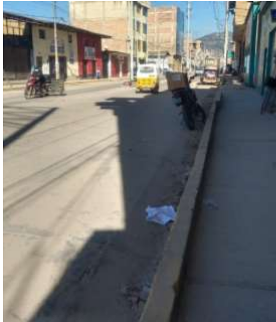
Figura 29. Ubicación visual (Cuneta 3)
