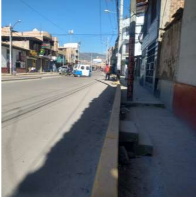
Figura 31. Ubicación visual (Cuneta 5)
