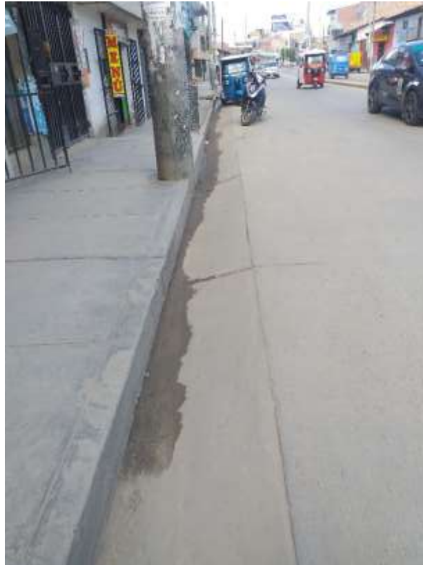
Ilustración 5: Avenida San Martín de Porres cuadra 9, no cuenta con buena pendiente para la evacuación de aguas.
