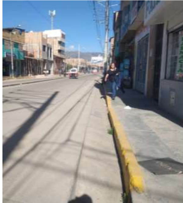
Figura 32. Ubicación visual (Cuneta 6)
