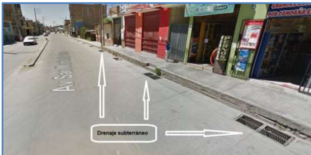
Figure 23. Drenaje subterráneo de la avenida San Martín de Porres
