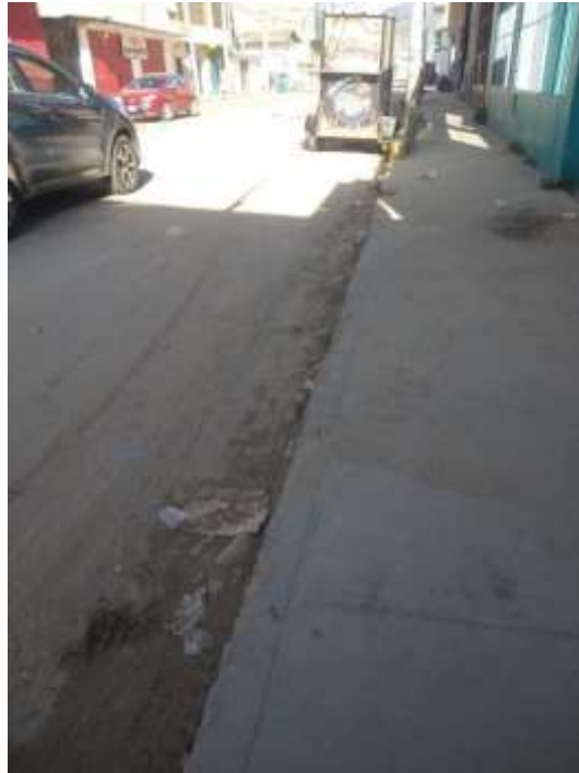
Figura 28. Ubicación visual (Cuneta 2)
