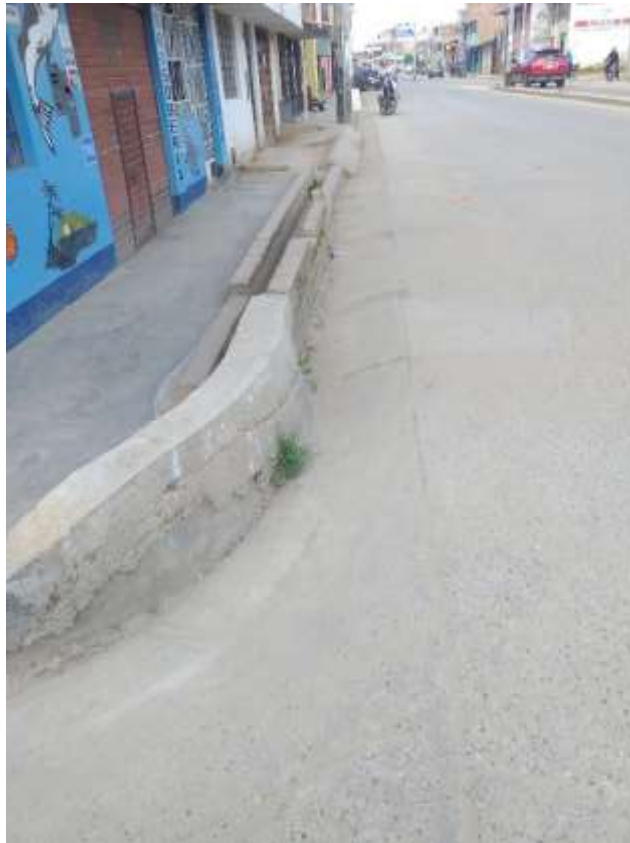
Ilustración 7: Avenida San Martín de Porres cuadra 10, tramos de sardinell para evitar el ingreso de agua de lluvia a las viviendas.
