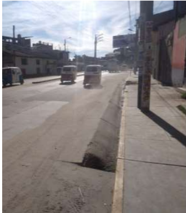
Figura 33. Ubicación visual (Cuneta 7)
