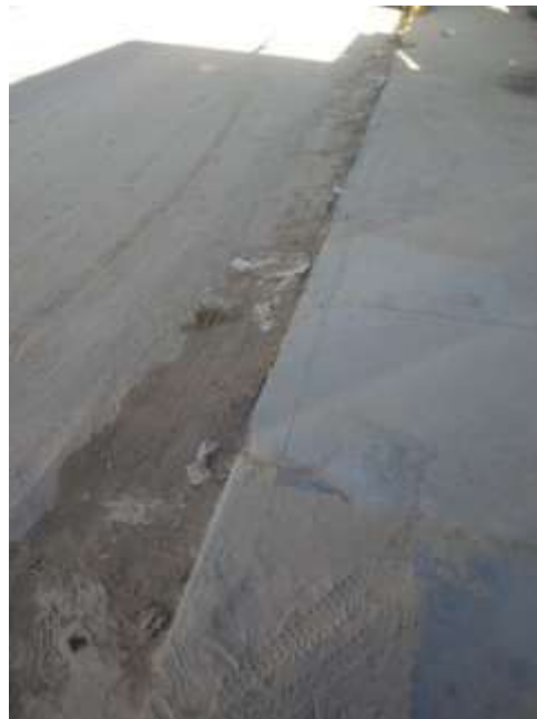
Figura 27. Ubicación visual (Cuneta 1)
