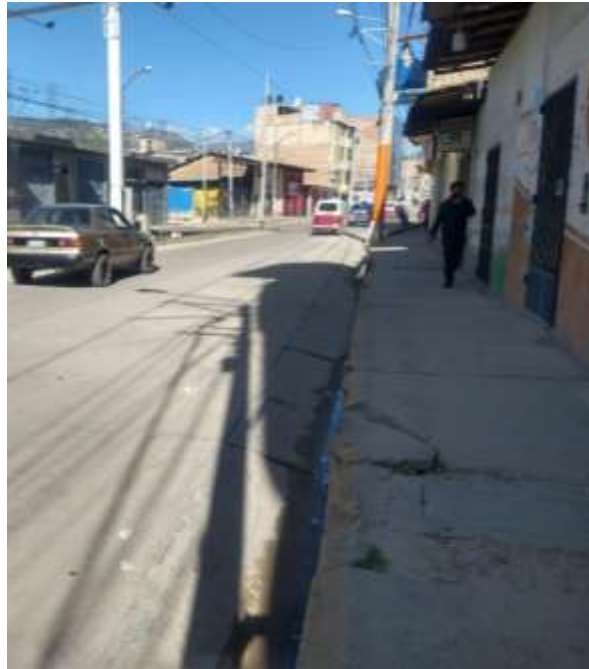
Figura 30. Ubicación visual (Cuneta 4)
