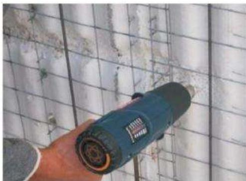
**INSTALACIONES SOBRE PANEL APLICANDO CALOR SOBRE EL PANEL PARA REALIZAR LA INSTALACIÓN**
