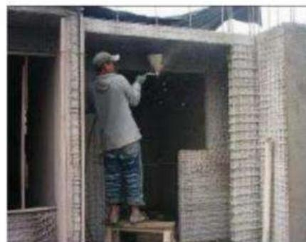
**PROCESO DE REVOQUE DE CAPA INFERIOR LOSAS ESTRUCTURALES PANELES EMMEDUE**
