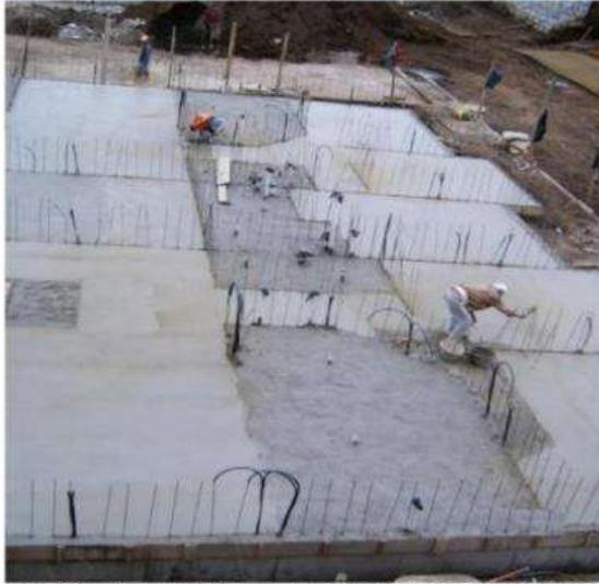
**CHICOTES DE VARILLA COMO ANCLAJES EN LOSA DE CIMENTACIÓN SISTEMA DE PAREDES PORTANTES**
