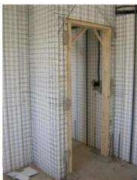
MEDIANTE UN CORTE SE ABREN LOS VANOS CORRESPONDIENTES A LAS ABERTURAS, CON EL ESPACIADO NECESARIO PARA LA COLOCACIÓN DE LOS MARCOS
