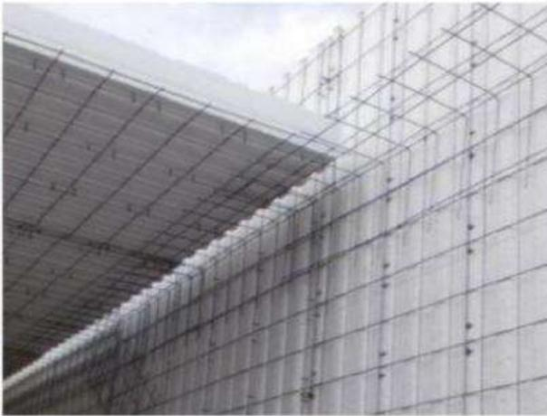
SE PROCEDE A REFORZAR MEDIANTE MALLAS ANGULARES LAS ESQUINAS EXTERNAS E INTERNAS DE LA CONSTRUCCIÓN, TANTO VERTICALES COMO HORIZONTALES, DANDO CONTINUIDAD A LA MALLA ESTRUCTURAL. TODOS LOS VÉRTICES DE LOS VANOS DEBEN SER REFORZADOS, TANTO EN EL LADO INTERNO COMO EXTERNO, ASIMISMO SE HACE USO DE LAS MALLAS DE REFUERZO PLANAS Y EN U..
