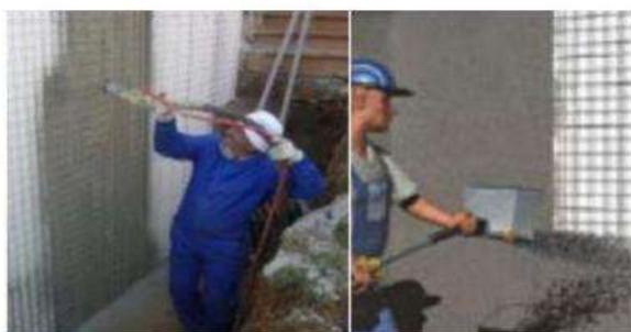
**PROCESO DE RECOQUE DE PANELES MURO**
