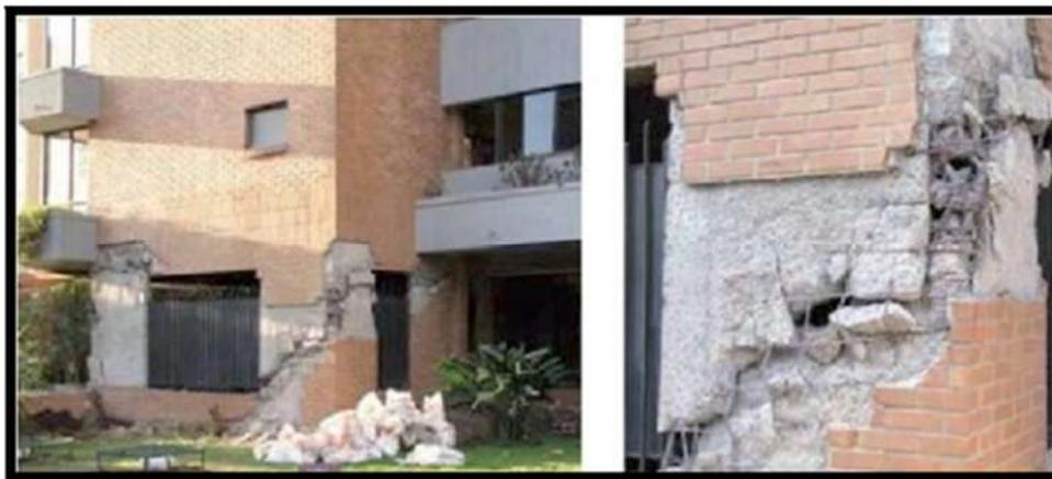
Gráfico 2.10. Falla por corte-fricción y tracción combinada en una columna. (San Bartolomé. 2004)
