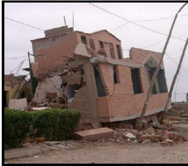
Gráfico 2.4. Vivienda colapsada por tener poca densidad de muros en la dirección de la fachada debido al terremoto de Pisco. (San Bartolomé, 2007)
