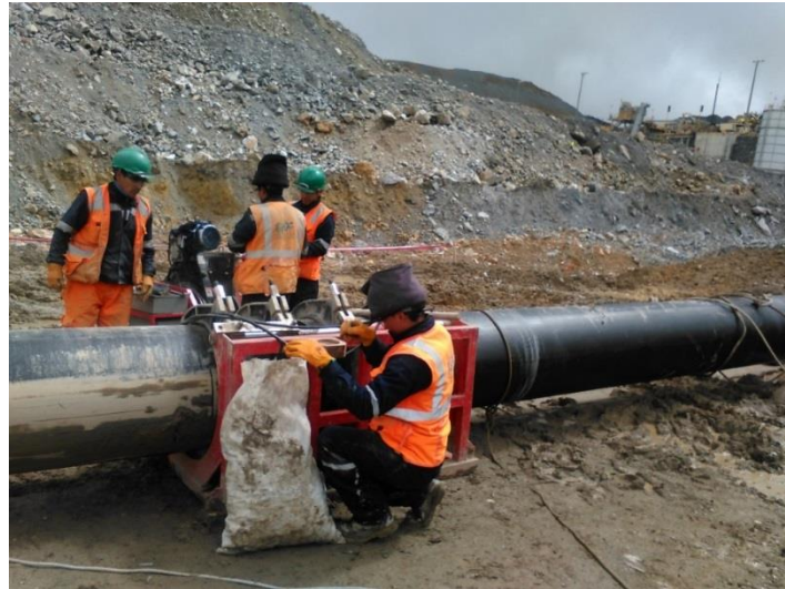
Figura N.º11. Personal brindando los servicios de soldeo por termofusión.
