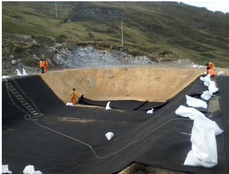
Figura N. °9. Personal realizando trabajo en geotextil.
