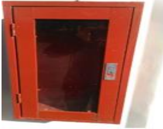
Figura N.º3. Caja de extintor sin extintor, Botiquines dañados
