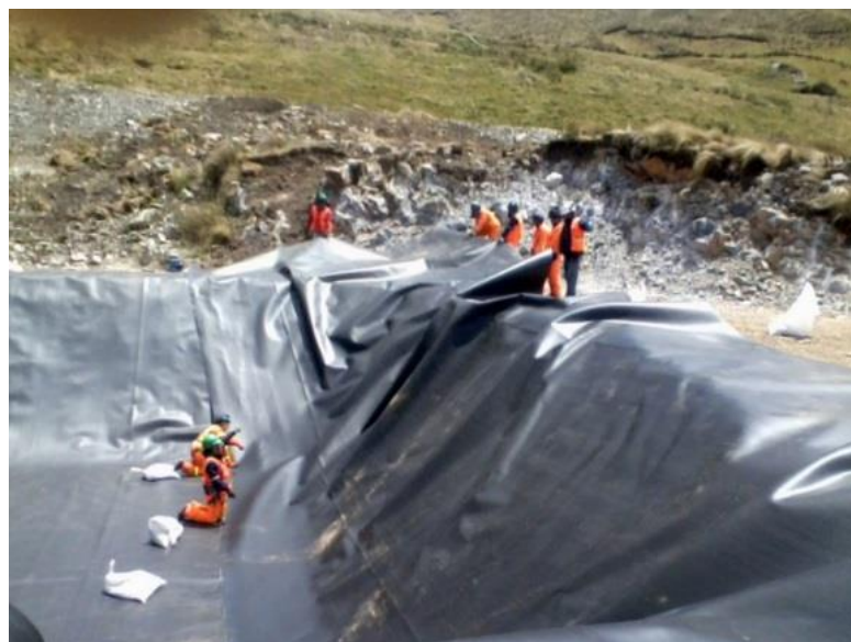
Figura N.°10. Personal realizando trabajo en geomembrana.
