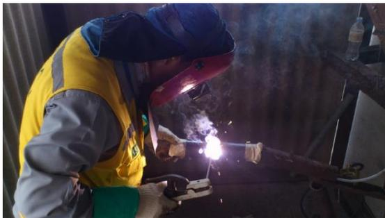
Proceso de calificación de soldadores en posición 2G, según ASME Secc. IX, con temperatura controlada y gas de respaldo. Material PN° 15E.
