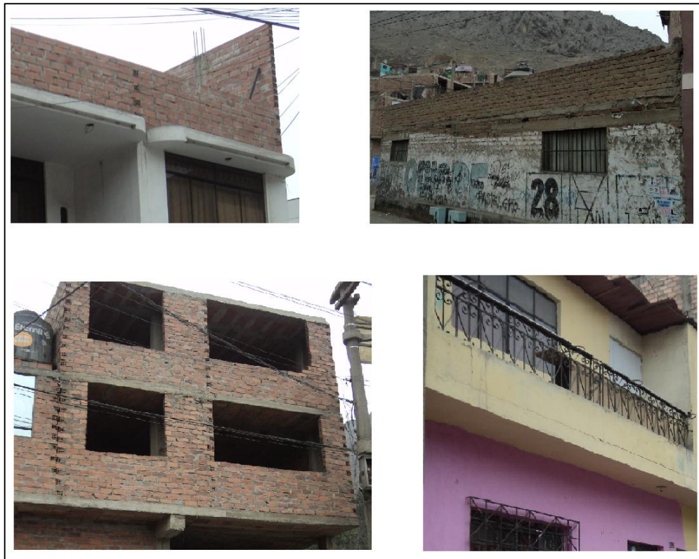
Gráfico n.º 9. Ejemplo de elementos no estructurales.
