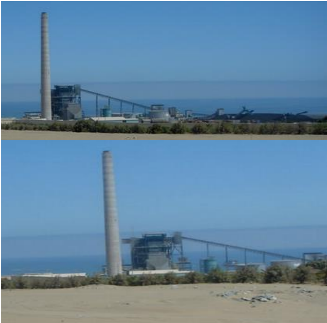
Figura 2.2. Vista General de la Central termoeléctrica ILO 21
