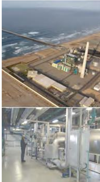
Figura 2.3. Vistas del Exterior e Interior de la Central termoeléctrica ILO 21
