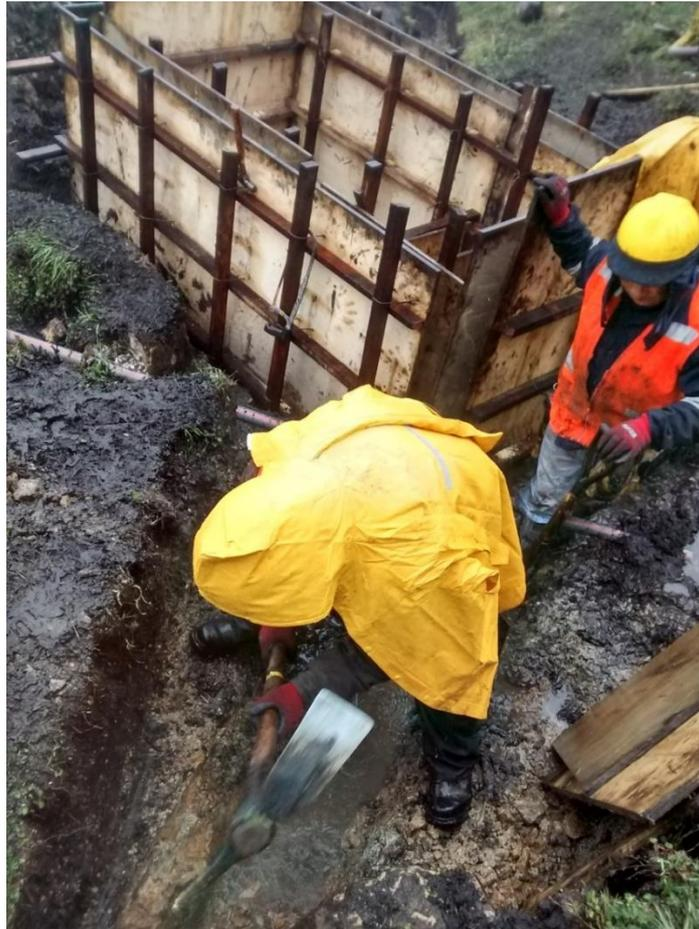
**Limpiando la zanja para colocación posterior de tubería.**
