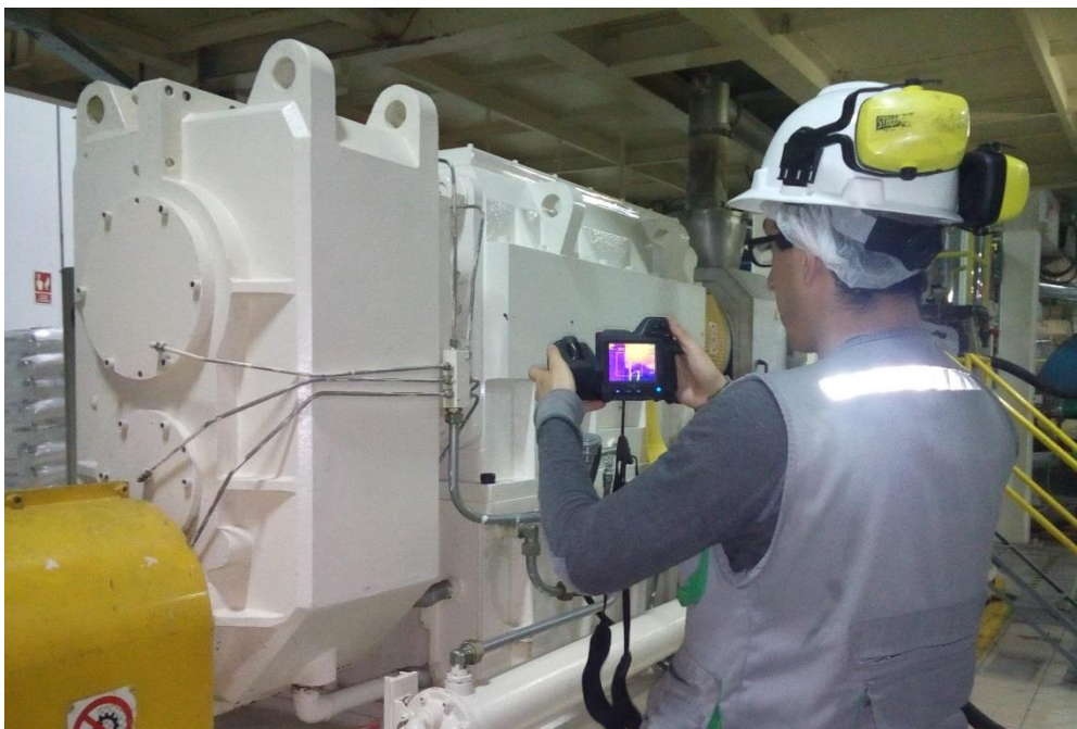
Figura n.º 13. Inspección con termografía en reductor principal de bopp 2.
