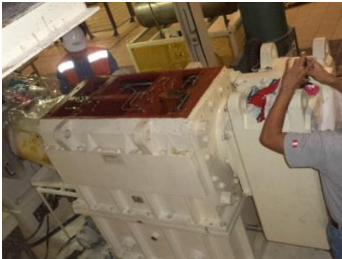
Figura n.º 14. Inspección visual del reductor principal en Bopp 1.
