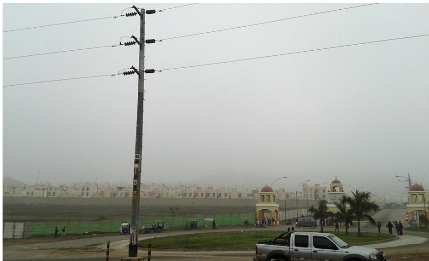
Figura n.º 2-1 Estructura N° 38 de la Línea de Transmisión de 60Kv.L-717
