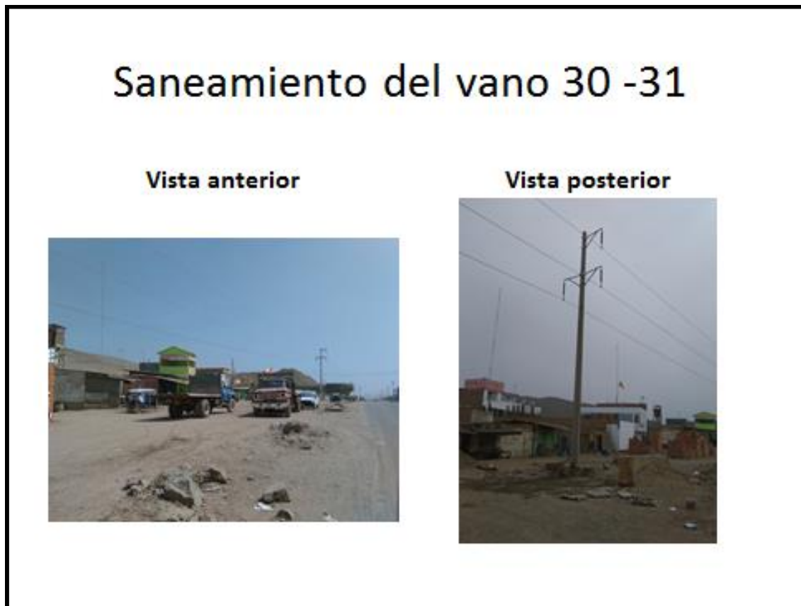
Figura n.º 4-4 Cumplimiento de la distancia vertical del vano 30 -31.
