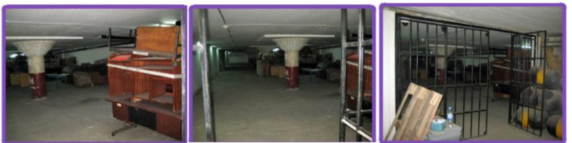
Figura n.º 3-5 Adecuación del sótano (450m2)
