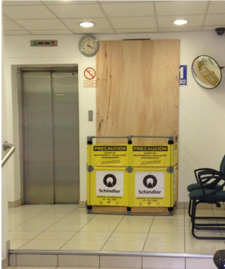
Este tipo de protección se colocara, cuando los trabajos se realizaran dentro del ducto del ascensor sin modificar y cambiar elementos de puertas de pasillo en cada planta.
