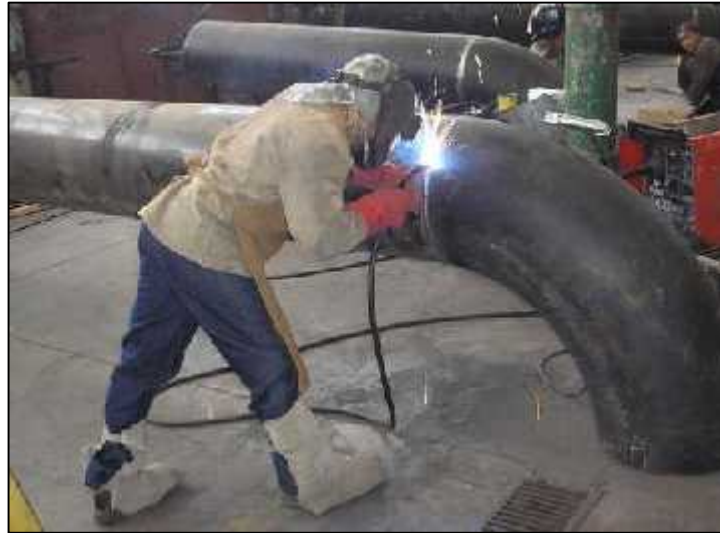
Figura 16. Proceso de soldadura FCAW.
