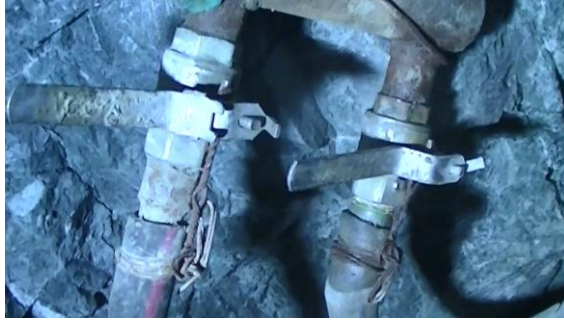
Fig. N° 8: Verificación de válvulas de agua y aire
