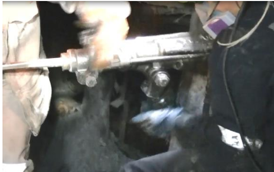
Fig. N° 17: Emboquillado del barreno
