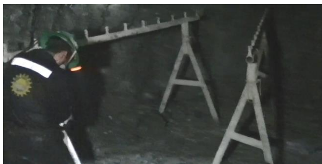
Fig. N° 7: Armado de plataforma de perforación
