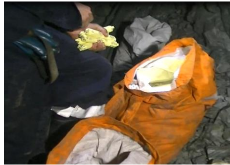
Fig. N° 22: Encebado del explosivo
