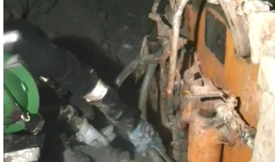
Fig. N° 30: Limpieza con pala Neumática
