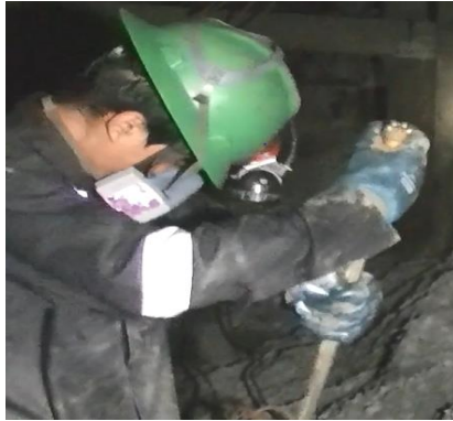
Fig. N° 16: Brocas de 36mm a las barras de perforación.
