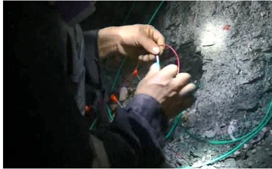
Fig. N° 24: Fig. Colocado de mecha
