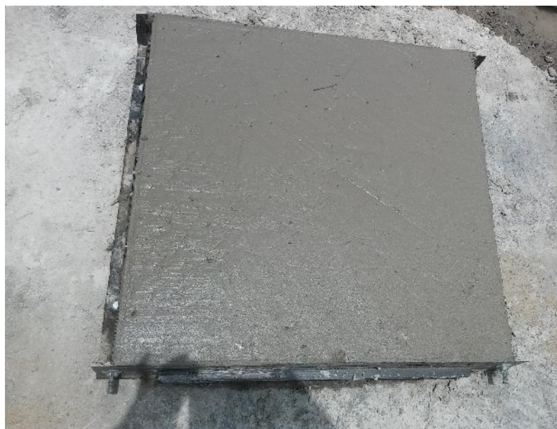
Figura 6.36. Paneles cuadrados con Concreto + Macrofibra Sintética 7kg/m 3
