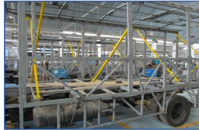
MONTAJE DE ESTRUCTURA
