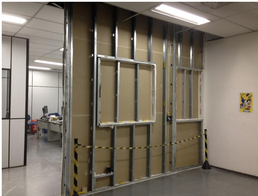
IMAGEN N° 17: Cambio en la infraestructura del área administrativa (Evidencia N° 02)
