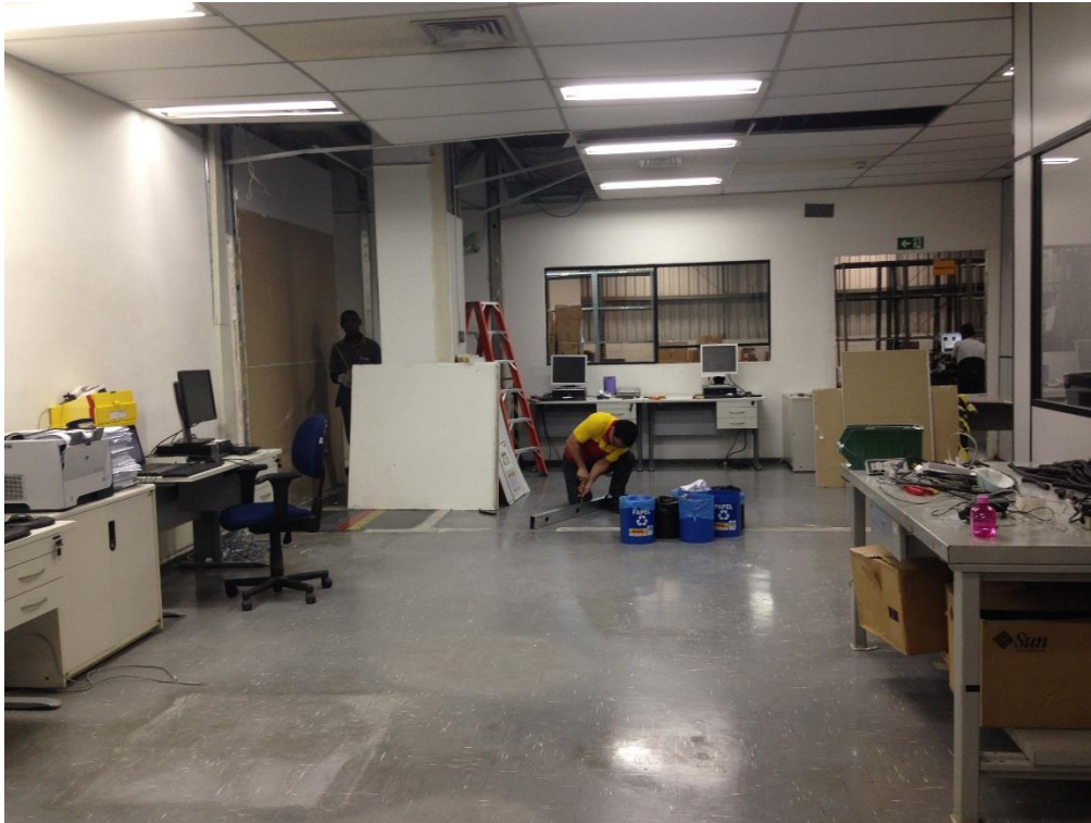
IMAGEN N° 20: Cambio en la infraestructura del área administrativa
