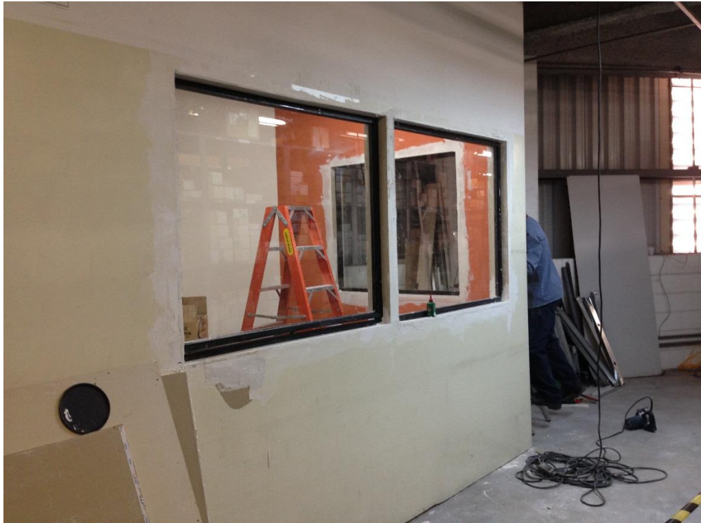
IMAGEN N° 26: Cambio en la infraestructura del área operacional
