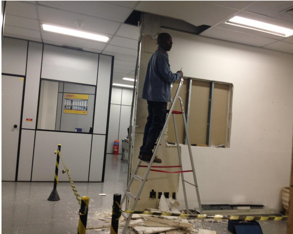
IMAGEN N° 16: Cambio en la infraestructura del área administrativa (Evidencia N° 01)
