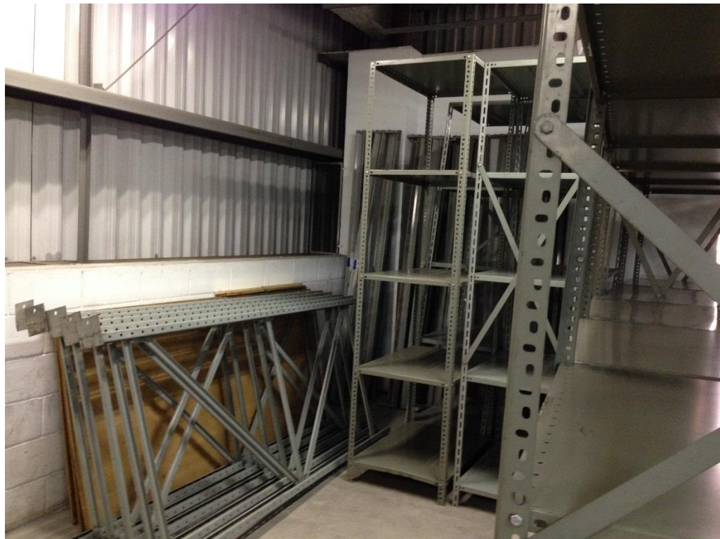
IMAGEN N° 25: Cambio en la infraestructura del área operacional
