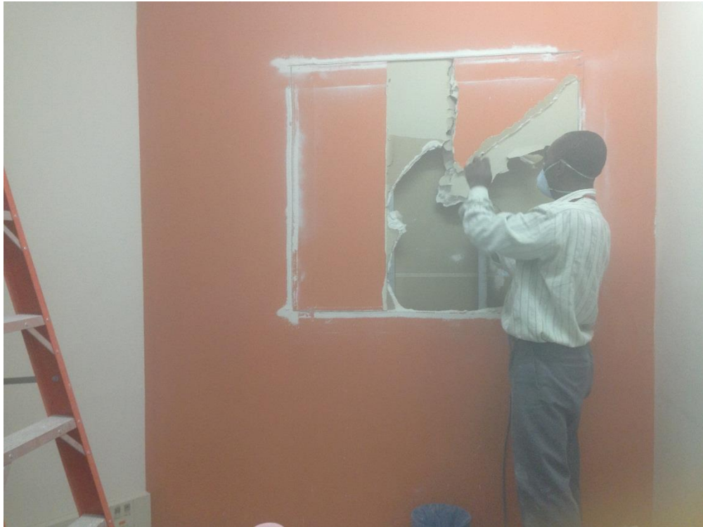
IMAGEN N° 18: Cambio en la infraestructura del área administrativa (Evidencia N° 03)
