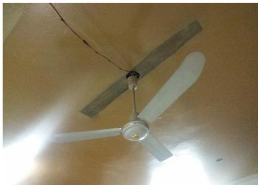
**Figura n° 12. Conexiones Inadecuadas en la ventilación**
