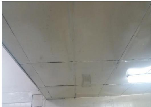
**Figura n° 6. Techos de fierro galvanizado**
