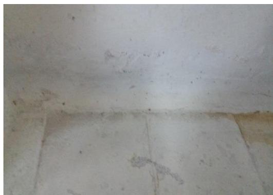
**Figura n° 4. Las uniones entre pared y pisos no son redondeados ni a media caña**
