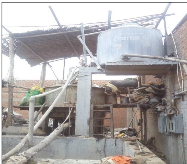
Figura 12: Falta orden y limpieza
