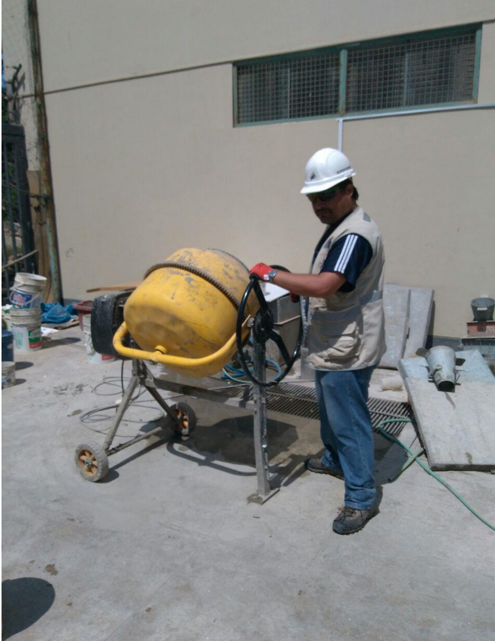
Fotografía 14: Mezcla de concreto en trompo.
