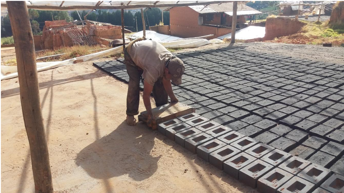
Figura n.º 10. 16. Extracción del ladrillo de la gavera.
