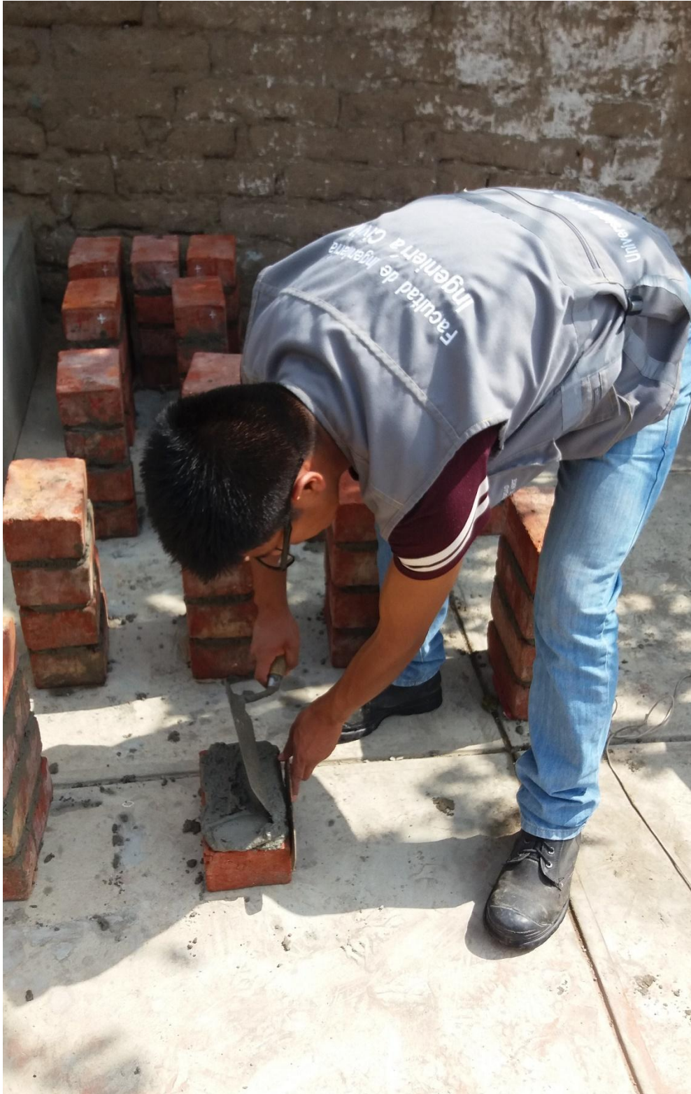
Figura n.º 10. 30. Elaboración de pilas de albañilería.
