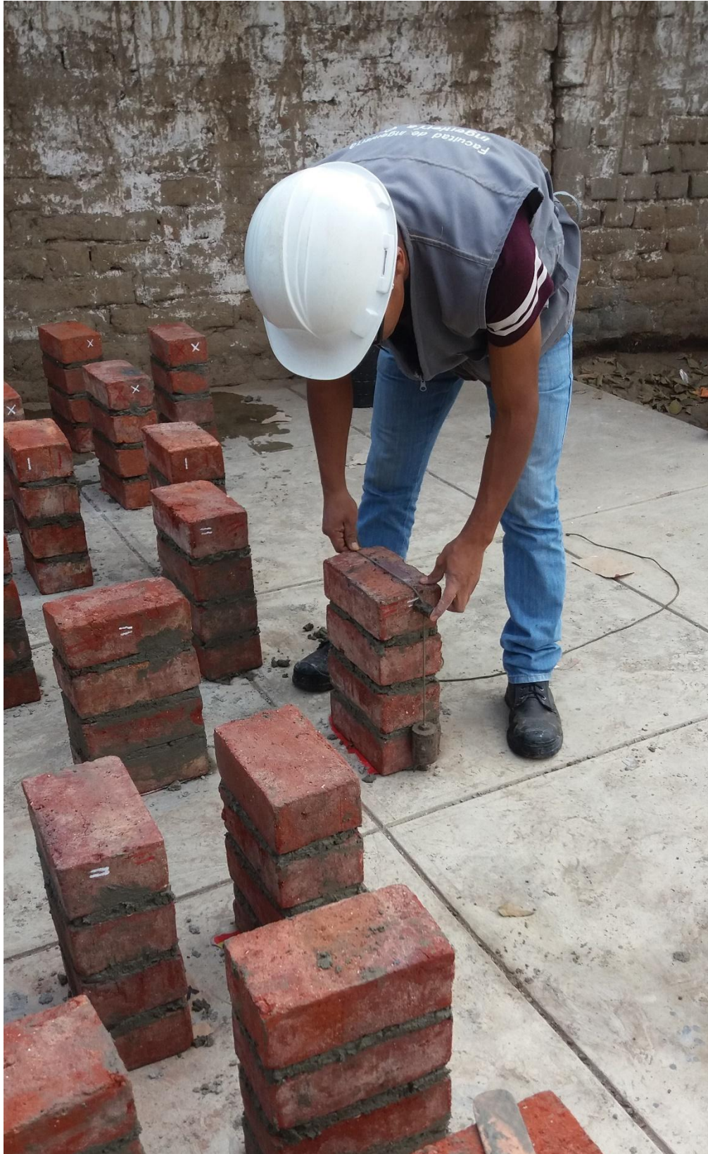
Figura n.º 10. 31. Nivelación de pilas con plomada.
