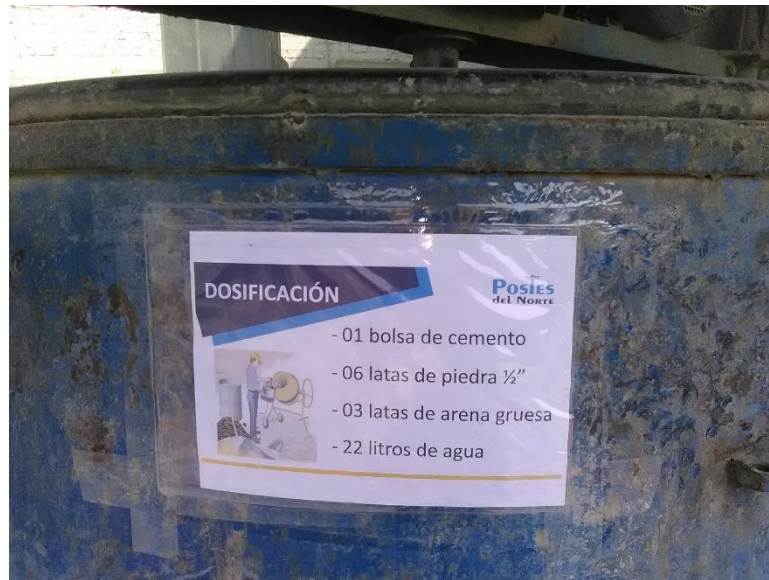
Figura n.º 15: Letrero colocado en mezcladora con dosificación de mezcla
