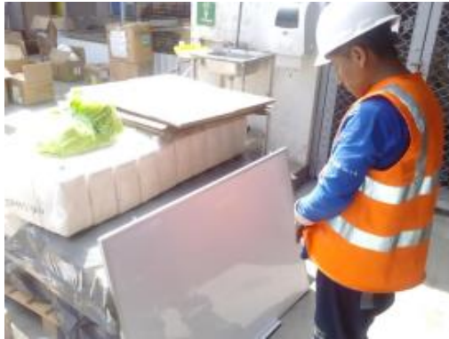
Figura 4 : Se recepción material equivocado.
