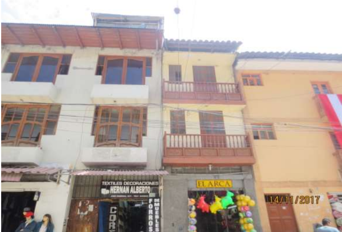
Figura 120: Cableado sobre balcones en Jr. José Sabogal
