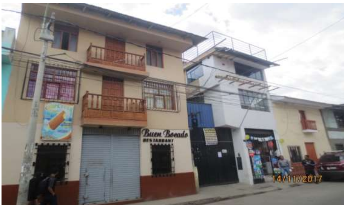
Figura 97: Cableado eléctrico desordenado y cercano a balcones en Jr. Amalia Puga
