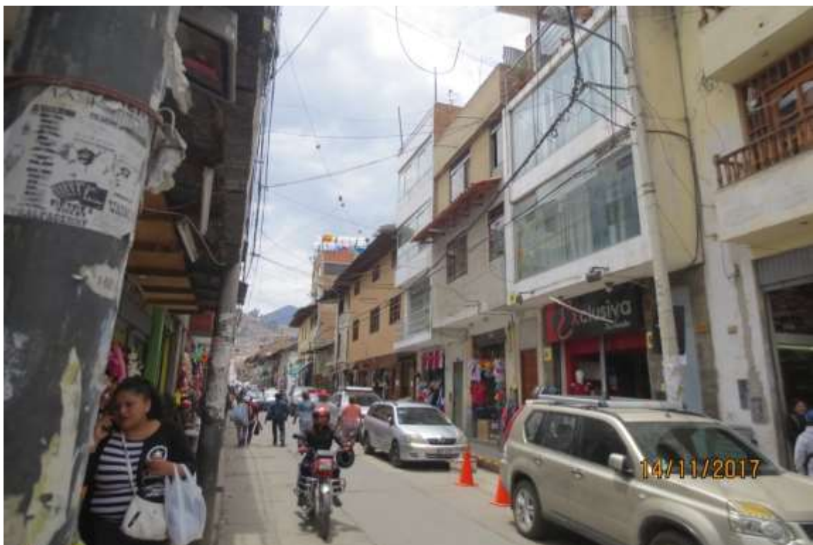
Figura 109: Cableado desordenado y cercano a ventanas
