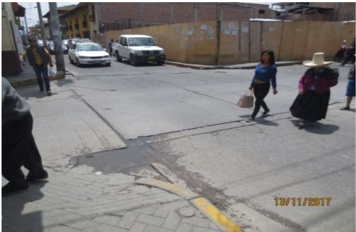
Figura 123: Rampa de acceso deteriorada
