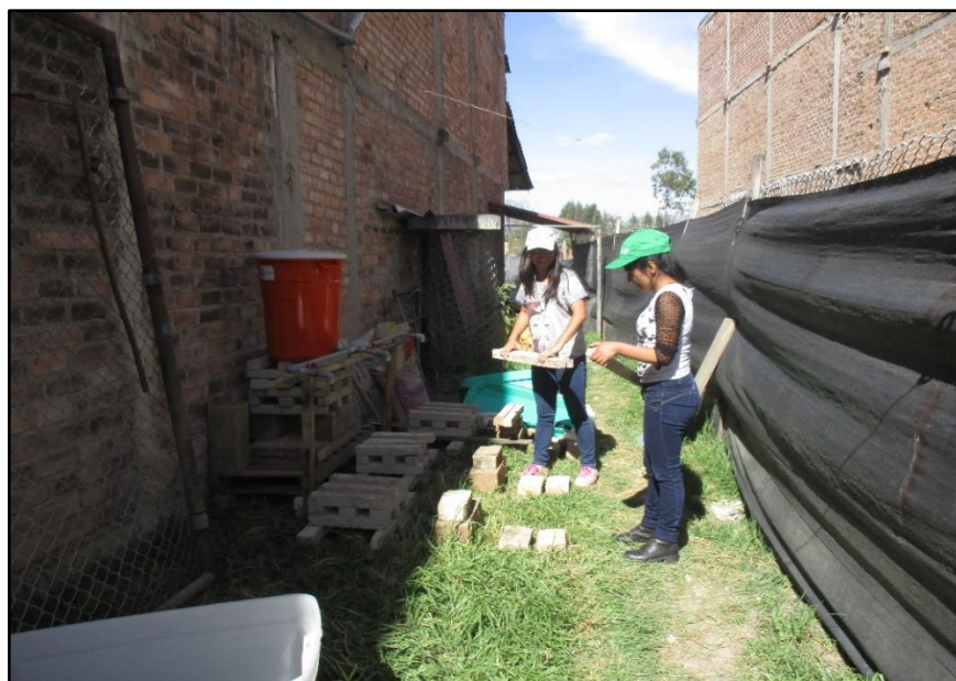
Figura 58: Construcción de los sistemas de humedales
