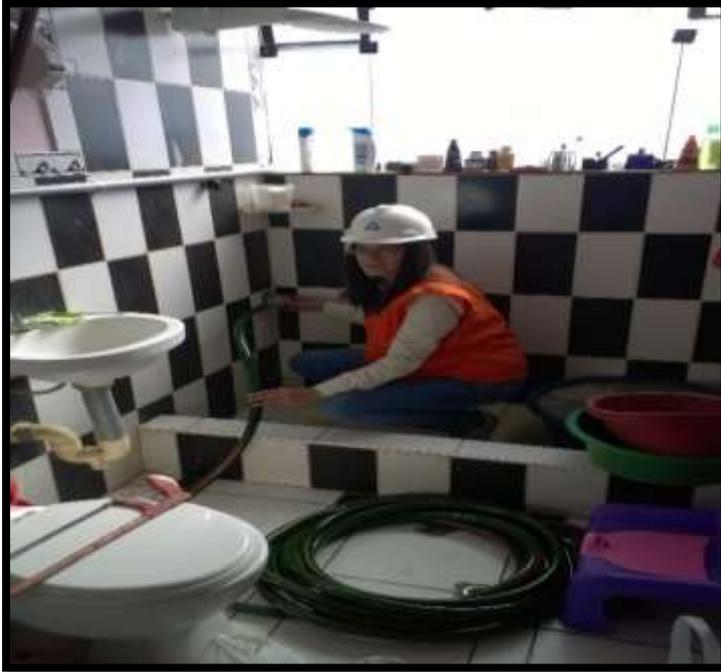
Conexión de manguera de jardín de 1” de diámetro a montante de recolección de 2” PVC SAL, por medio de abrazaderas y reducciones.
