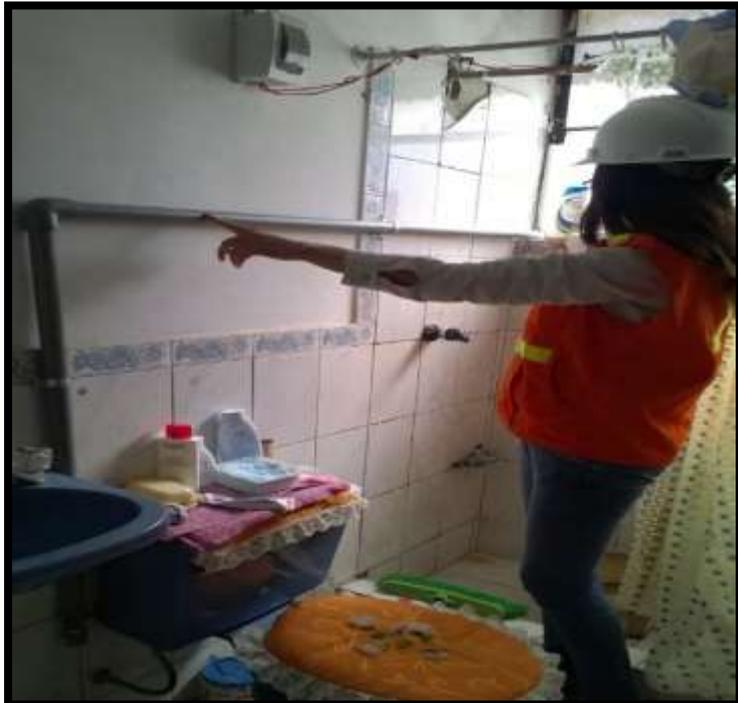
Tubería de PVC SAP 1", que baja de tanque elevado, ingresa por la ventana del baño a sanitario, sujetadas con abrazaderas de 1".
