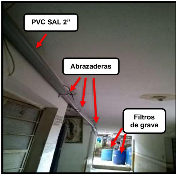
Las montantes de tubería PVC SAL de 2" atraviesa todo el pasadizo del primer piso, hasta llegar a los filtros de grava.
