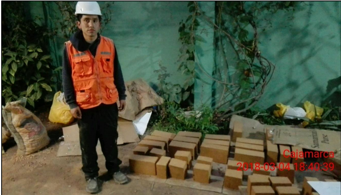
Figura N° 42 Colocación de los adobes para el secado.
