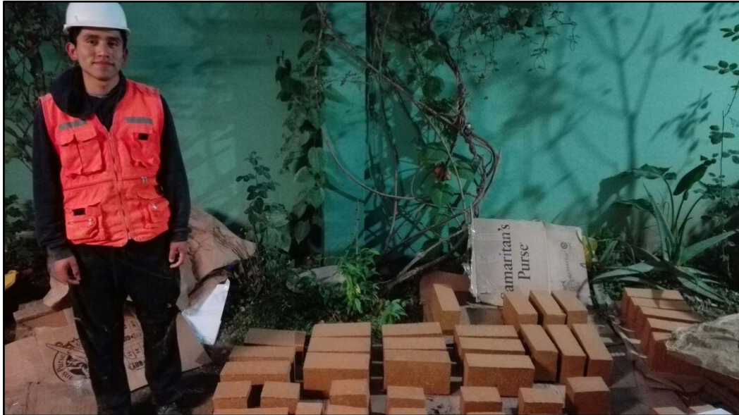
Figura N° 21 Adobes compactados listos para su secado.
