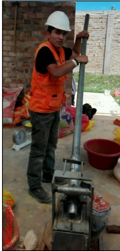
Figura N° 40 Utilizando el CINVA RAM para la elaboración de adobes.
