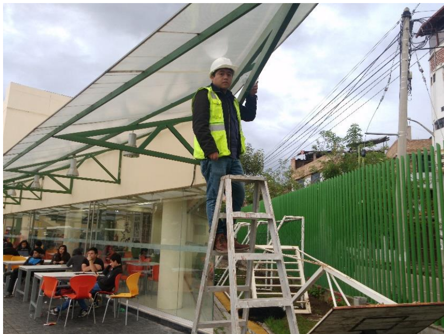
Fotografía N° 4. Colocación de Placa receptora de CSS.
