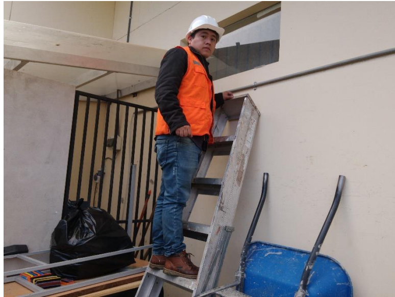
Figura 9. Colocación de Placa receptora de CSS.
