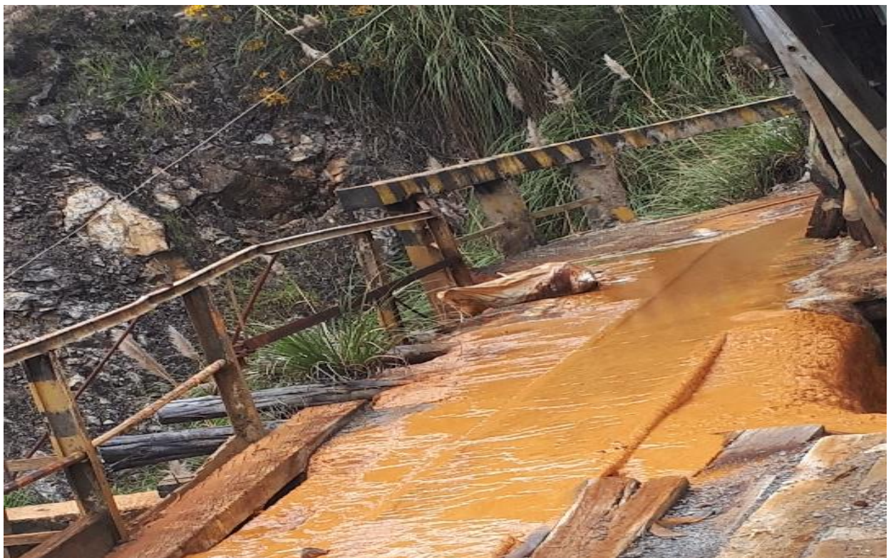
Figura 7: Entrada a la bocamina
