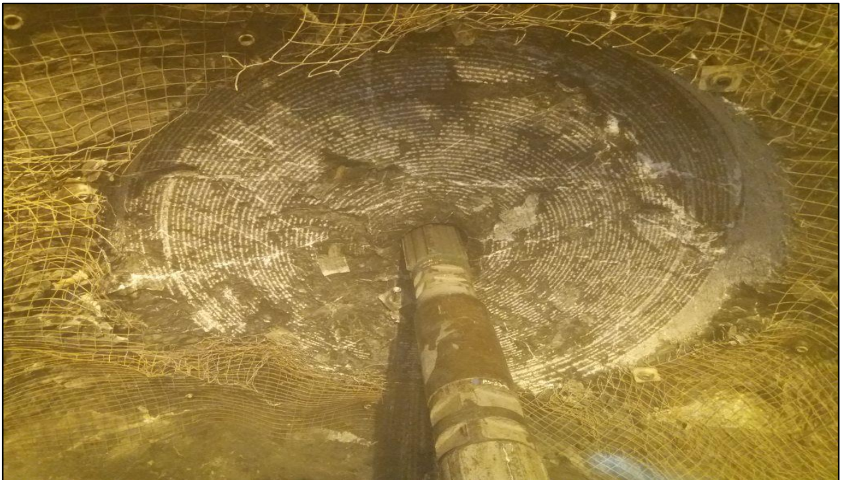
Foto 4.5. Vista de la cara techo de la perforación rimado en el pie de la RB piloto nv120 / NV4120, mina socorro.
