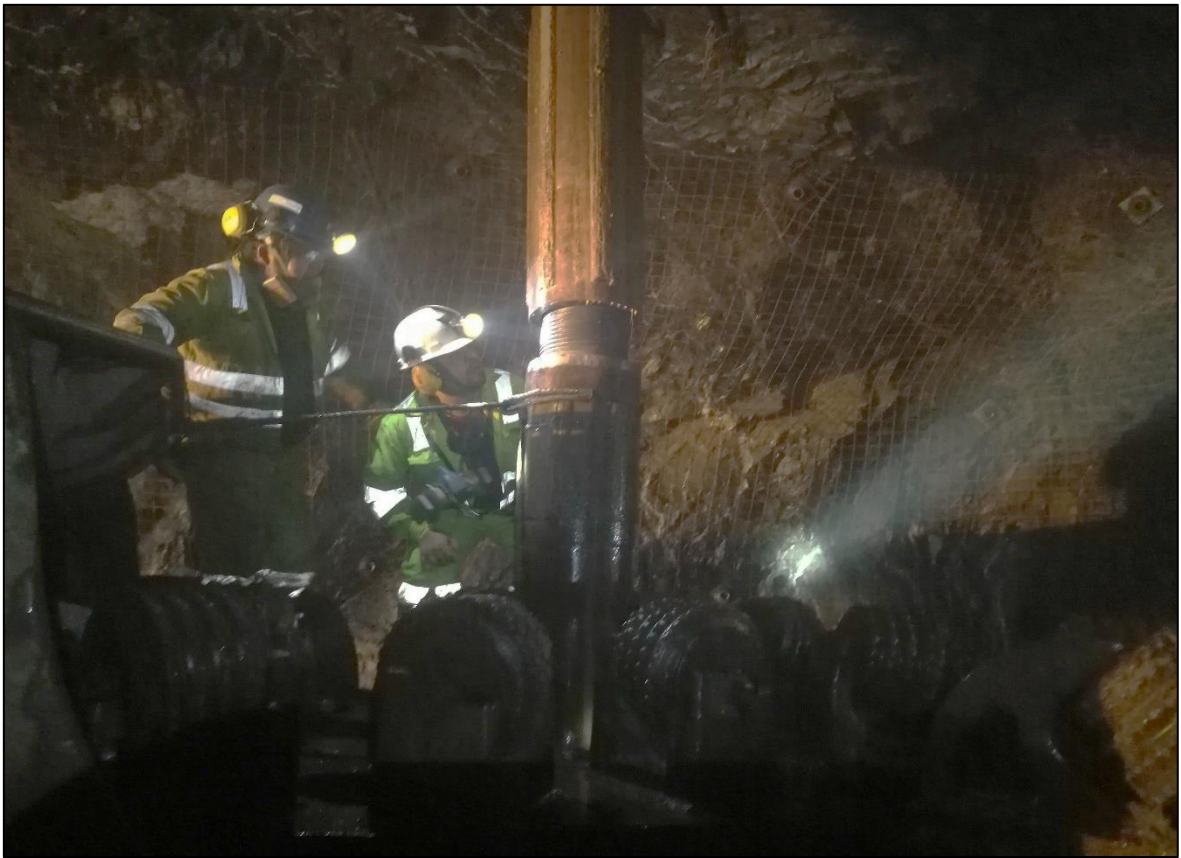
Foto 4.3. Conexión de la columna de barras al escariador en el pie de la RB piloto nv120 / NV4120, mina socorro.
