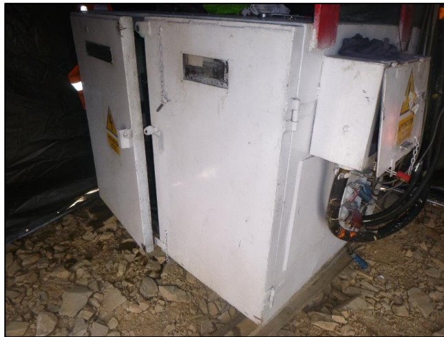
Figura 10: Unidad eléctrica asegurada con candado de bloqueo.
