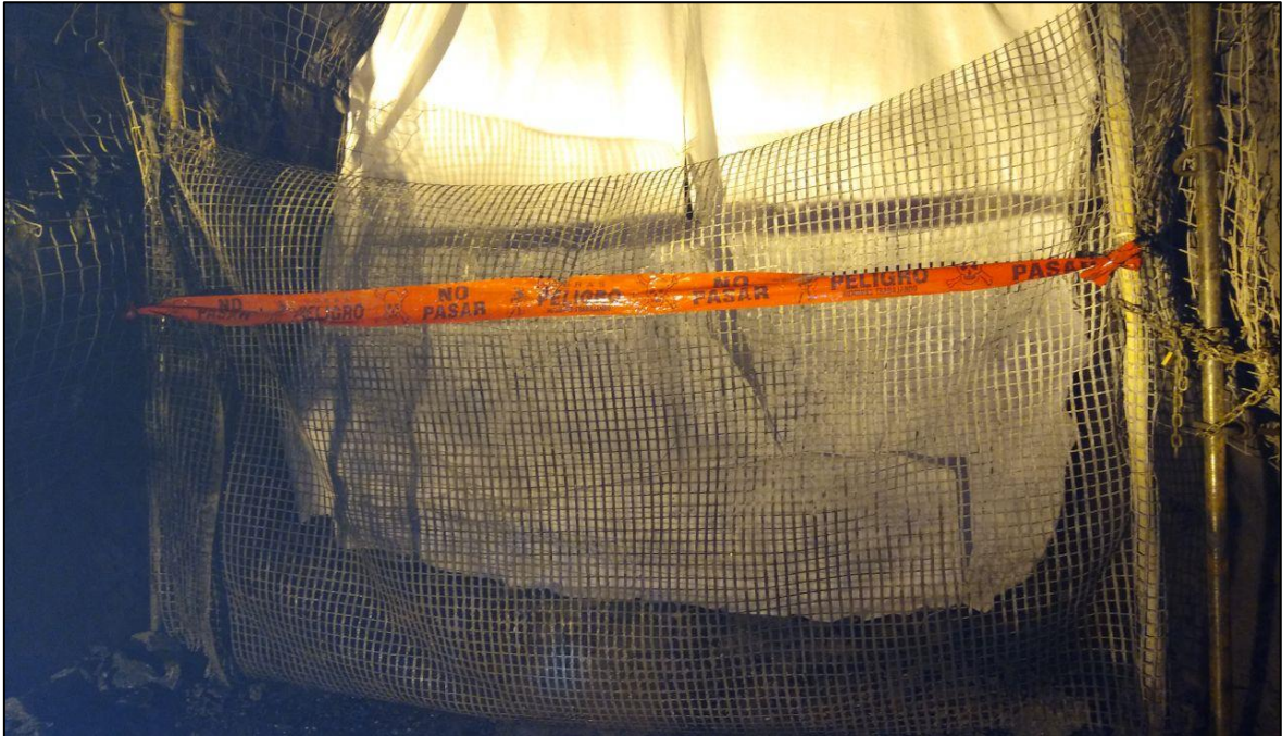
Foto 4.1. Tapón del pie de la RB piloto nv120 / NV4120, mina socorro.
