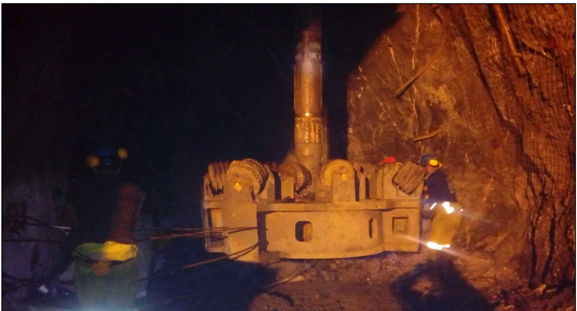
Foto 4.4. Trabajos de preparación para el torque de escariador, en el pie de la RB piloto nv120 / NV4120, mina socorro.
