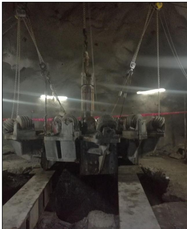
Foto 4.6. Retiro de escariador en la cámara RB piloto nv120 / NV4120, mina socorro.
