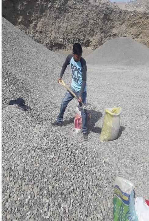
*Figura 28: Obtención del agregado fino y grueso*
