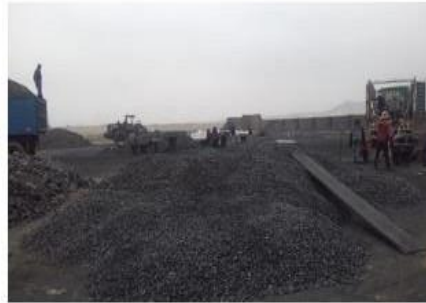
LLEGA AL DEPÓSITO
