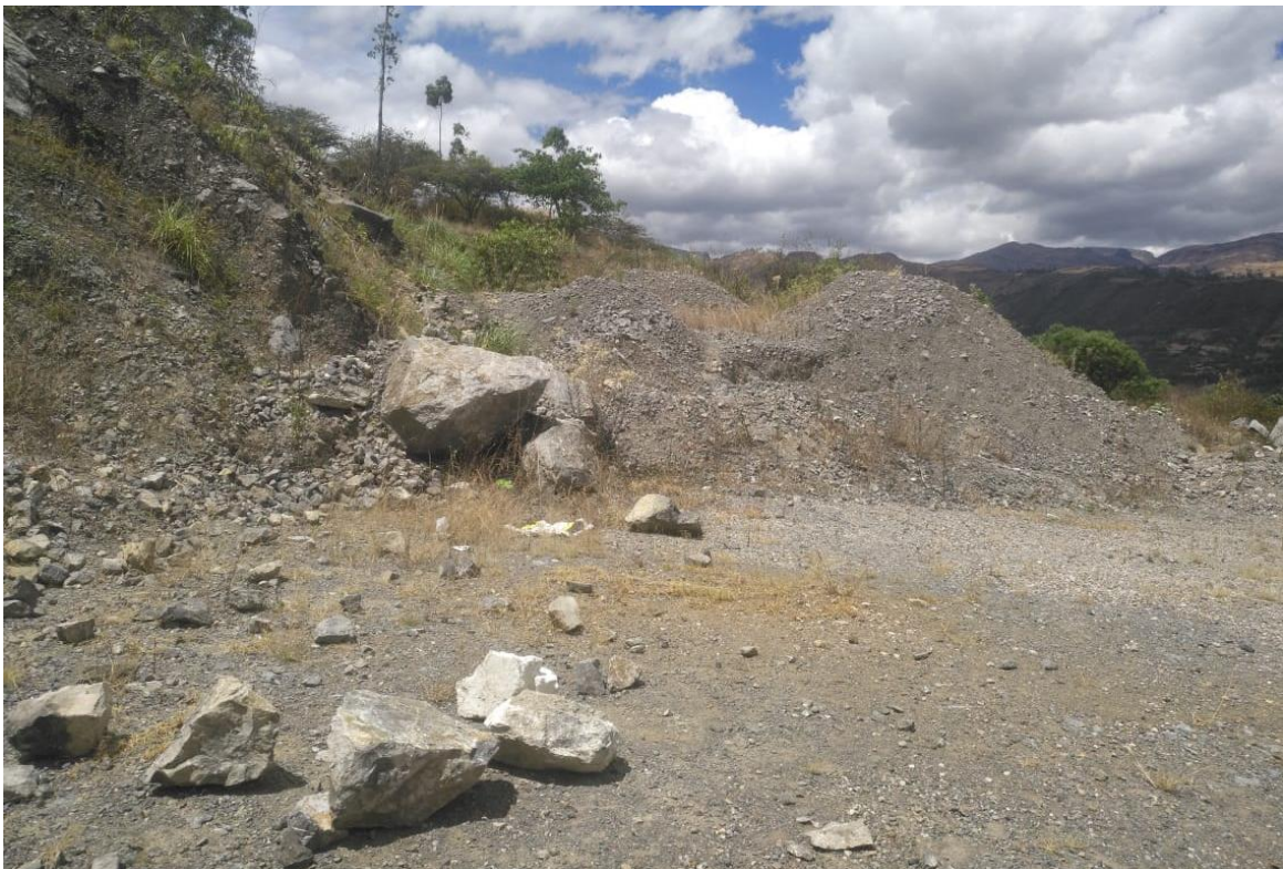
Figura 23. Zona de desmonte 2.
