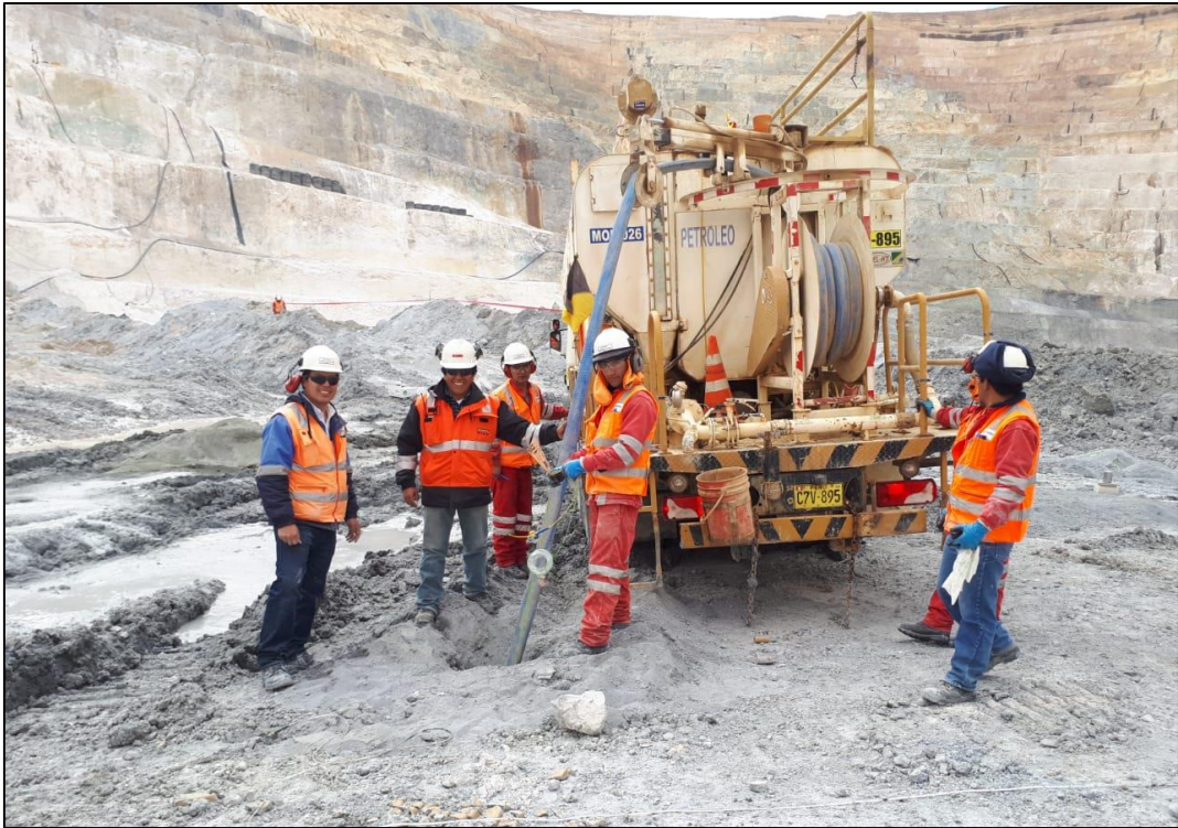
Figura 17: Carguío de taladros.
