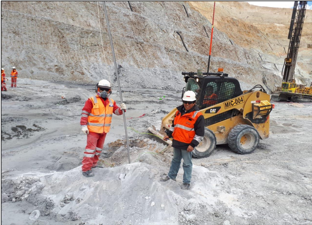
Figura 15: Verificación de taladros.
