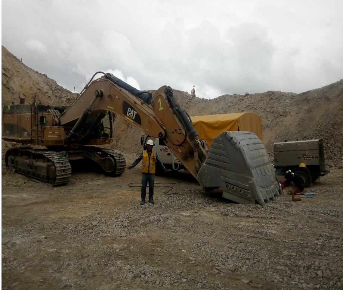
Foto 5. Excavadora 374 DL en mantenimiento preventivo de cucharón.
