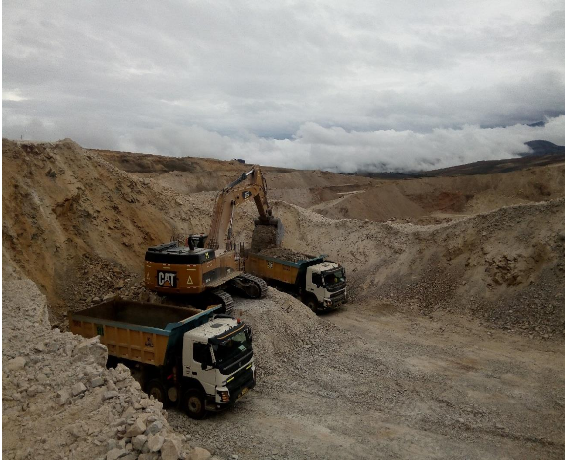
Foto 4. Excavadora 374 DL haciendo carguío en el banco 3300.
