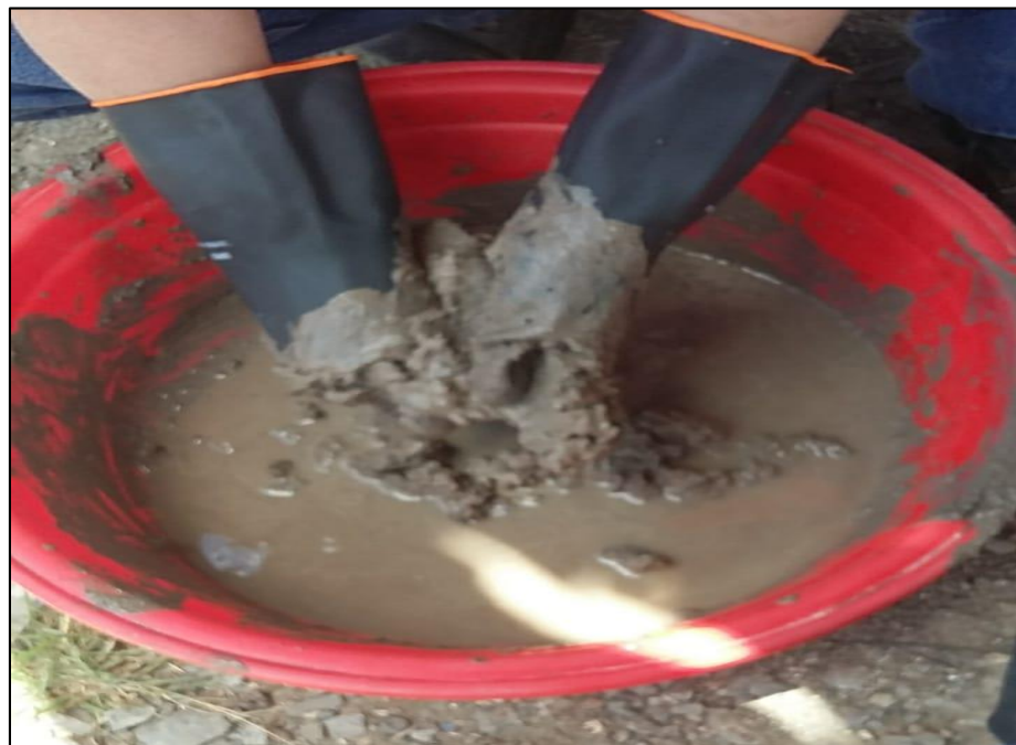
Figura 13. Agua utilizada en las briquetas.
