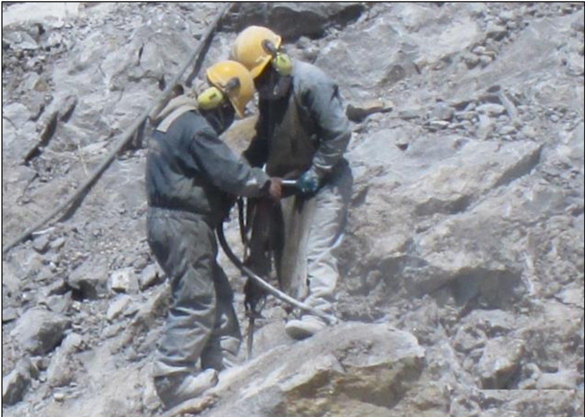
Figura 4. Perforación de la roca caliza. Fuente: Elaboración propia, (2018).
