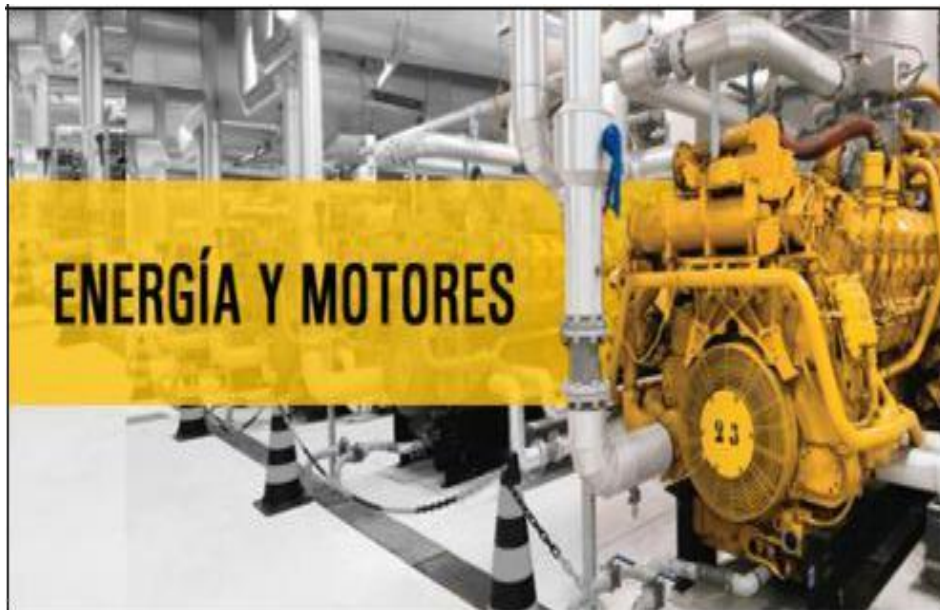
Figura n° 3 Maquinaria de la empresa
