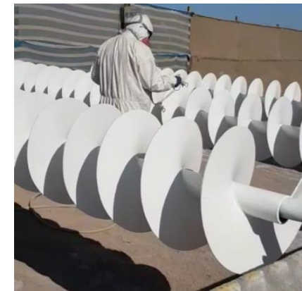
PREPARACIÓN Y APLICACIÓN 2° CAPA PINTURA
