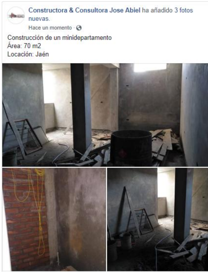
Figura n°. 49 Obra privada
