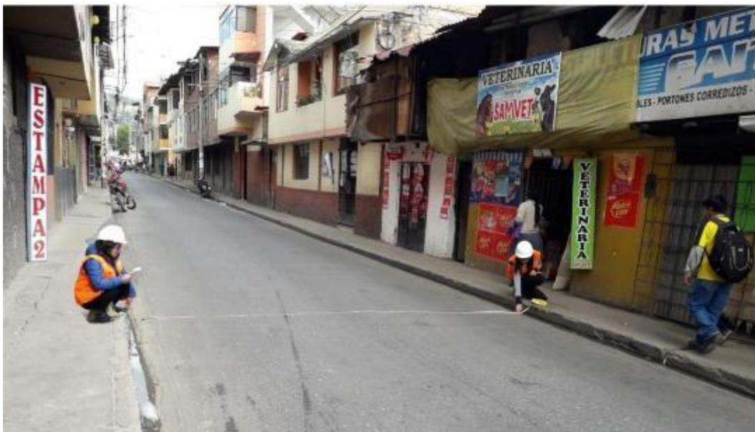
Foto 16 Medición del ancho de calles por donde van las líneas A, C, D y P13.
