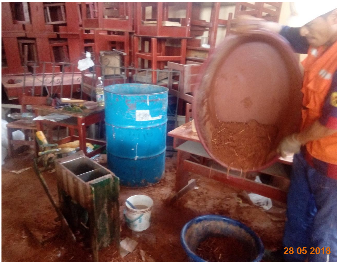
Figura 42. Preparación de la mezcla para la elaboración de los bloques compactados
