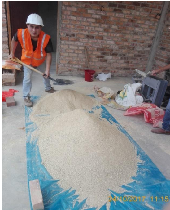
Figura N° 26. Mezclado de todo el material extraído de la cantera.
