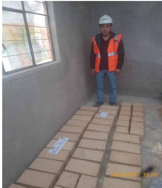
Figura N° 31. Secado de los adobes convencionales y con adición de paja toquilla. Finalmente se secó el adobe por un tiempo de 28 días protegido del viento para no generar rajaduras.
