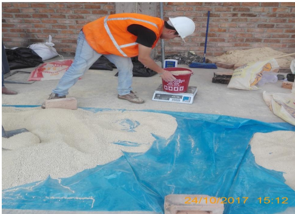
Figura N° 27, Pesando 9 kilogramos de material para cada adobe.
