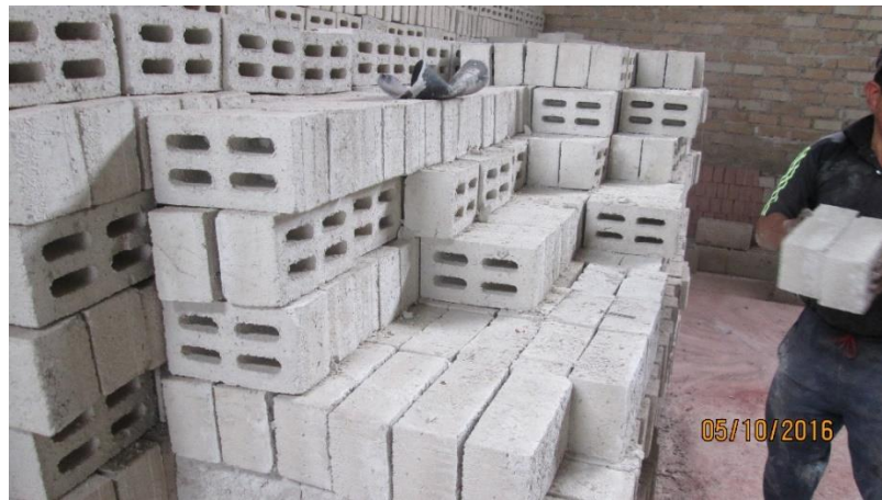
Figura 32. Acarreo del ladrillo de concreto para ser trasladado al campus UPNC.
