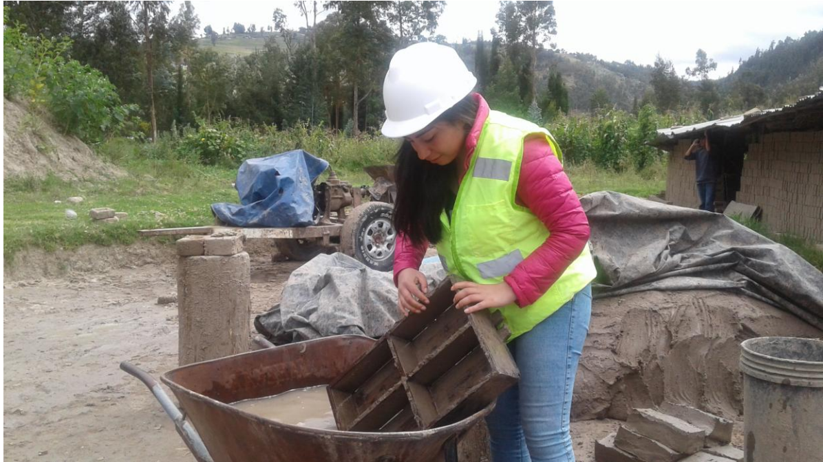
Fotografía N° 4: Limpieza de molde para adobes.
